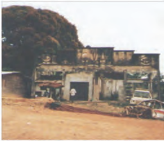
Empresa CVA en Guinea Ecuatorial. «Junto a las secretas acepciones propias de CVA, encontramos estas siglas en dos registros técnicos: uno médico – CVA Cardiovascular Accident – y otro eléctrico – CVA Compact Volume Amplifier.»
