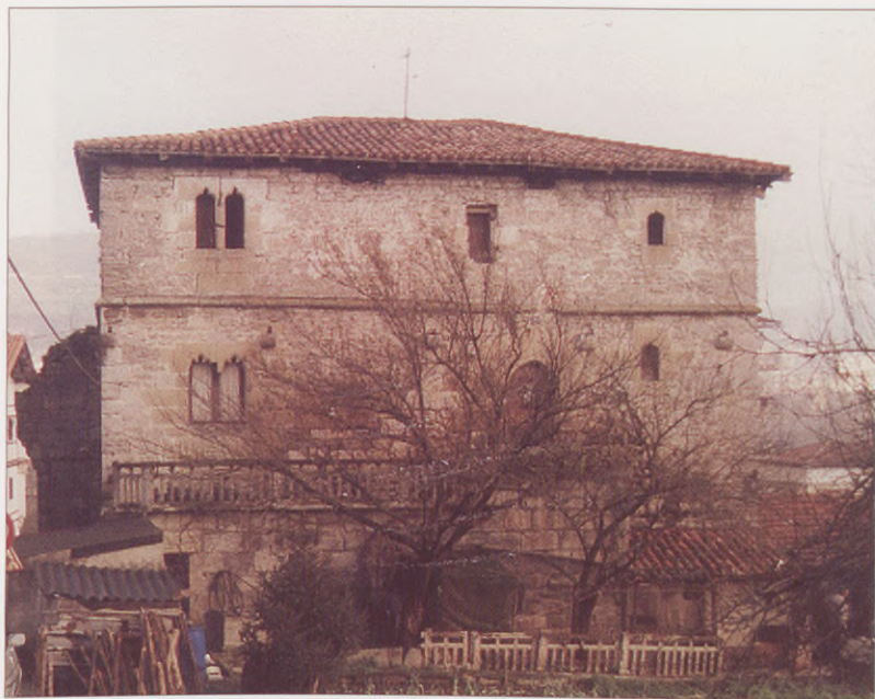
Hegoaldeko fatxadaren ingurunea berreskuratu baino lehen. Entorno de la fachada sur antes de la recuperación.
