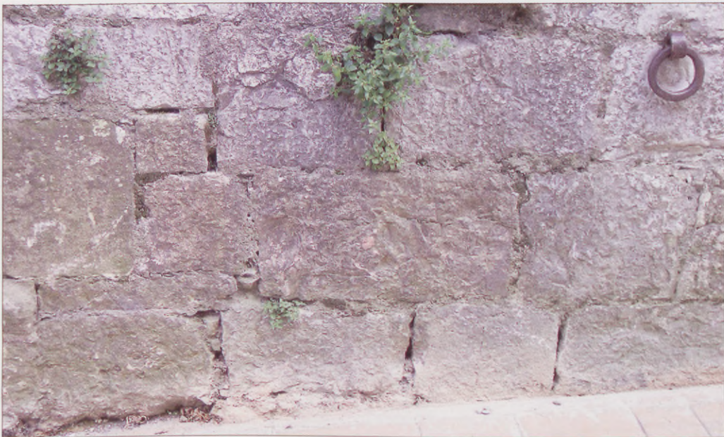
Behealdeko silarri kretazeoen (arrosak) xehetasuna, eta horien gainean jurasikoak (grisak). Detalle de los sillares inferiores cretácicos (rosáceos) y los jurásicos sobre ellos (grises).
