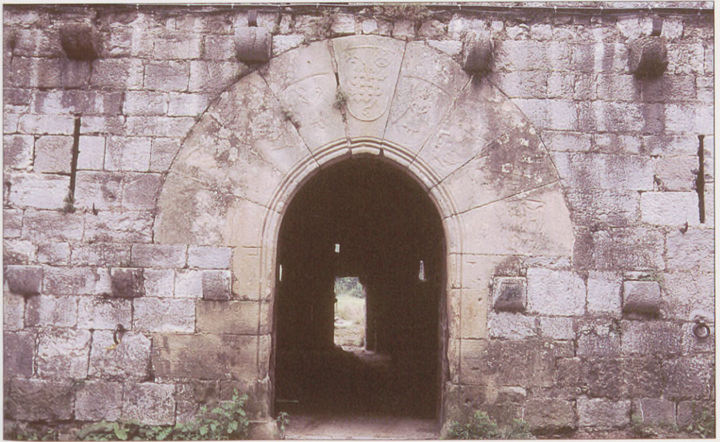
Sarrera nagusiko arkua eta saietarak. Lehen solairuko arkua eta lehoi konopiala. Argazkia: J. M. Pemán. Arco y saeteras del acceso principal. Arco y vano conopial de la primera planta. Fotografía: J. M. Pemán.
