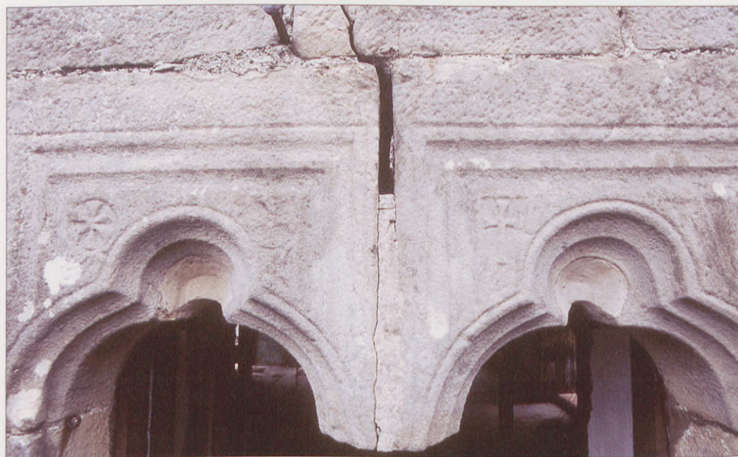
Hegoaldeko fatxadaren lehen solairuko lechio bikoiztua. Argazkia: J. M. Pemán. Vano geminado de la primera planta de la fachada sur. Fotografía: J. M. Pemán.
