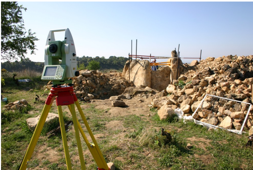
Fig. 5.- Estación total utilizada para las medidas topográficas (volumétrico y coordenadas de los puntos de apoyo).
