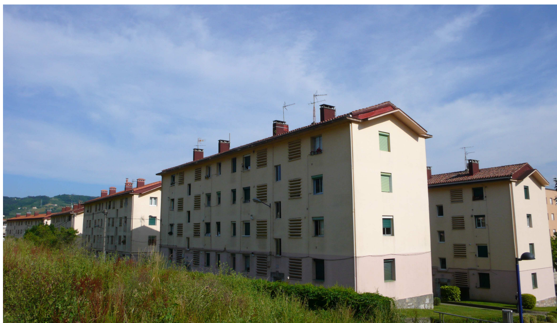
Polígono de viviendas Sagasti Alde, Hernani. 1955-7. (Antiguo "Grupo San Antonio"). 112 viviendas. Arquitecto: Alustiza Garagarza, Luis. Promotor: Obra Sindical del Hogar y de Arquitectura. Fotografía del autor.
