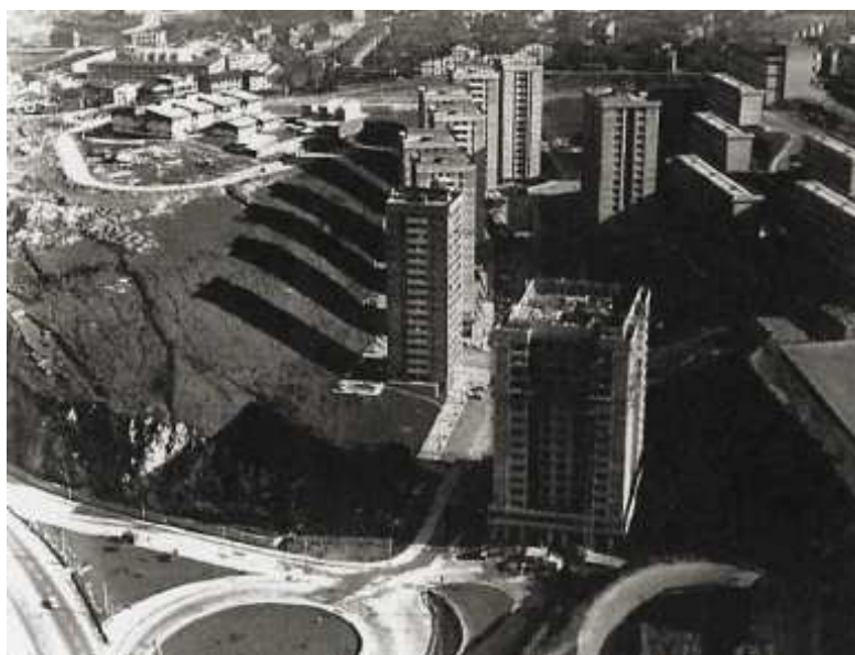
Edificios en construcción en los barrios de Agustinas, Beraun y Capuchinos. Fotografías extraídas de Historia de Rentería . Archivo Municipal de Rentería.
