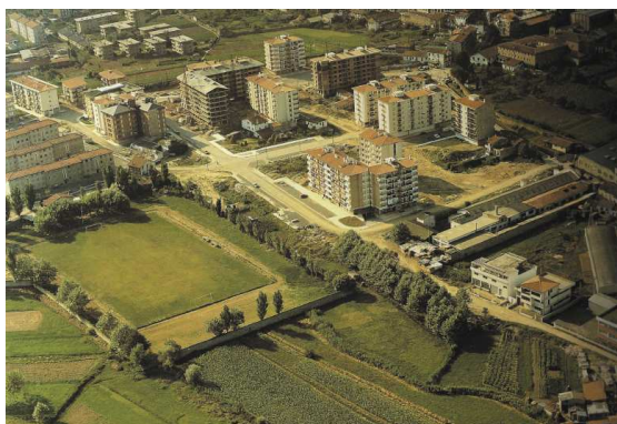
Barrio de Azken Portu, en construcción. 1971.
