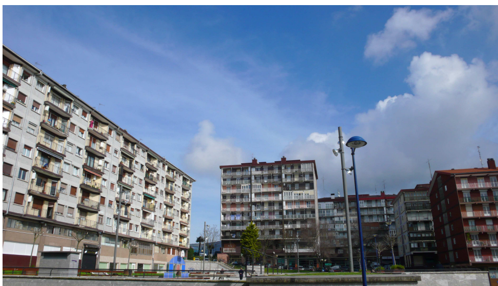
Barrio de Beraun en Errenteria. Planta baja y entre seis y ocho alturas. 2.126 viviendas. 1972. Fotografía del autor.
