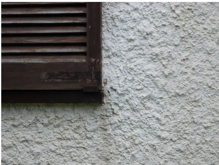
Revoco a la Tirolesa. Edificio de 4 viviendas en Aresti, 5 de Zarautz, construido a mediados de la década de los sesenta. Fotografía del autor.
