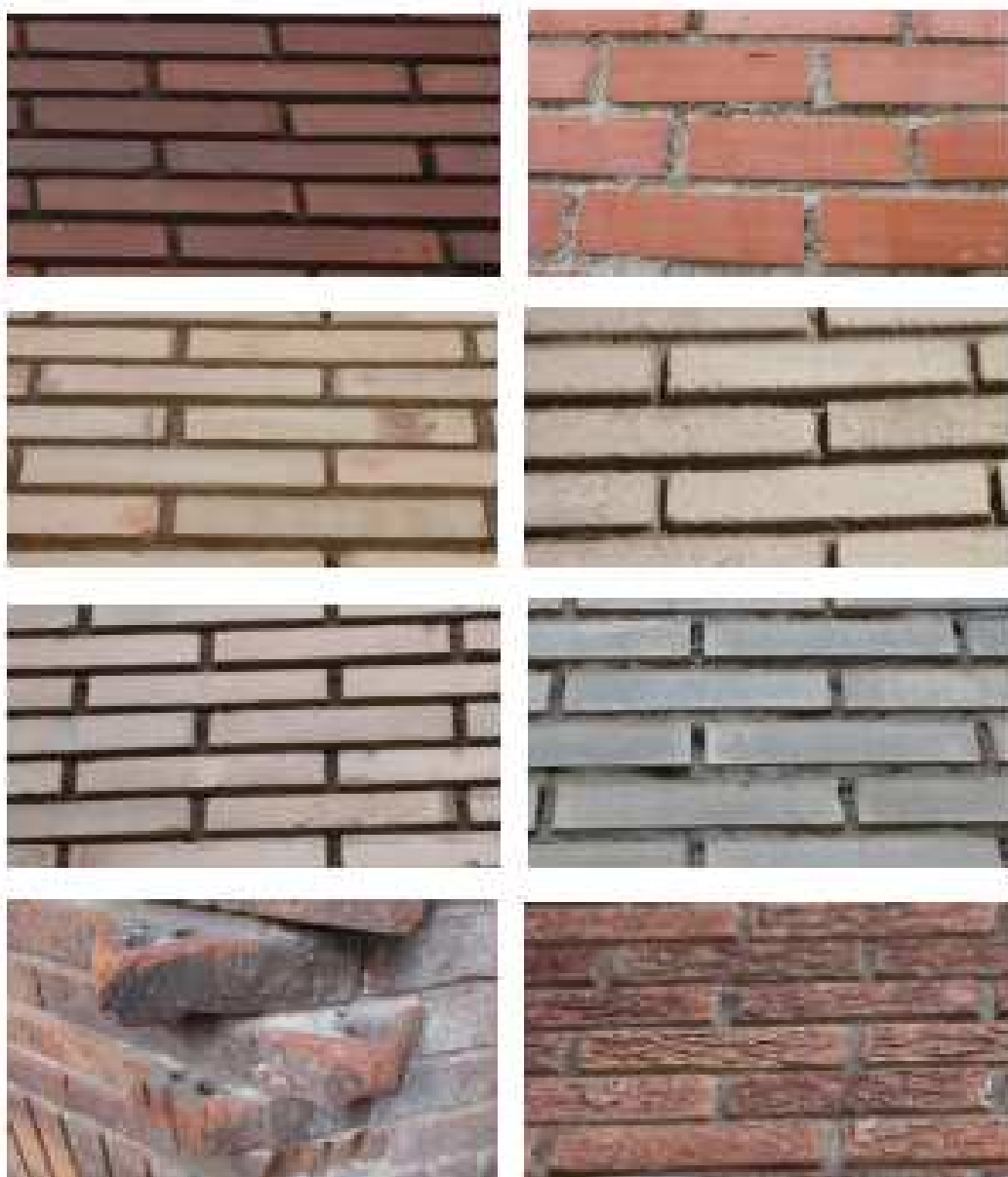
Diferentes paños de fachada de la época realizados con fábrica de ladrillo caravista. Fotografías del autor.
