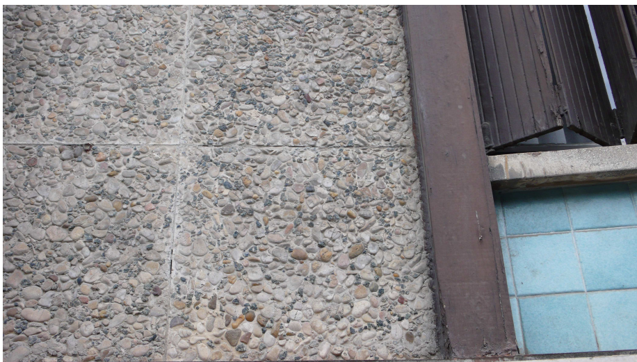
Revestimiento de fachada a base de baldosa de canto rodado de río. Edificio situado en Lope de Irigoien, 11 de Irun, construido en la segunda mitad de los años sesenta. Fotografía del autor.
