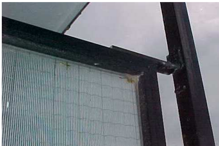
Panel de vidrio armado de la barandilla original del edificio de 8 viviendas en Zumalakarregi, 19 de Zarautz, proyectado por Roberto Martínez Anido en 1964. Fotografía del autor.
