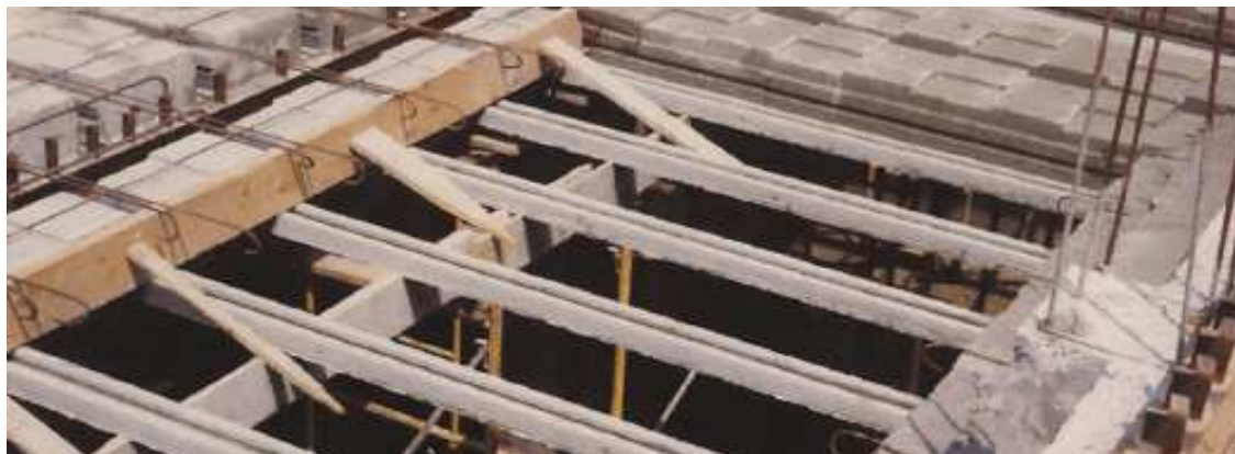
Primera puesta en obra de una vigueta PERFIL "U" de "PRENASA". Edificio de 30 viviendas en Torre Luzea, 2 de Zarautz, proyectado por Roberto Martínez Anido. Fotografía cedida por Pedro y Alberto Eizaguirre.
