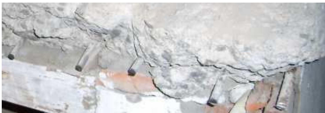
Barras lisas de acero de la losa de escalera del edificio de 36 viviendas en Nafarroa, 27-33 de Zarautz, proyectado en 1967 por Roberto Martínez Anido. Fotografía del autor.
