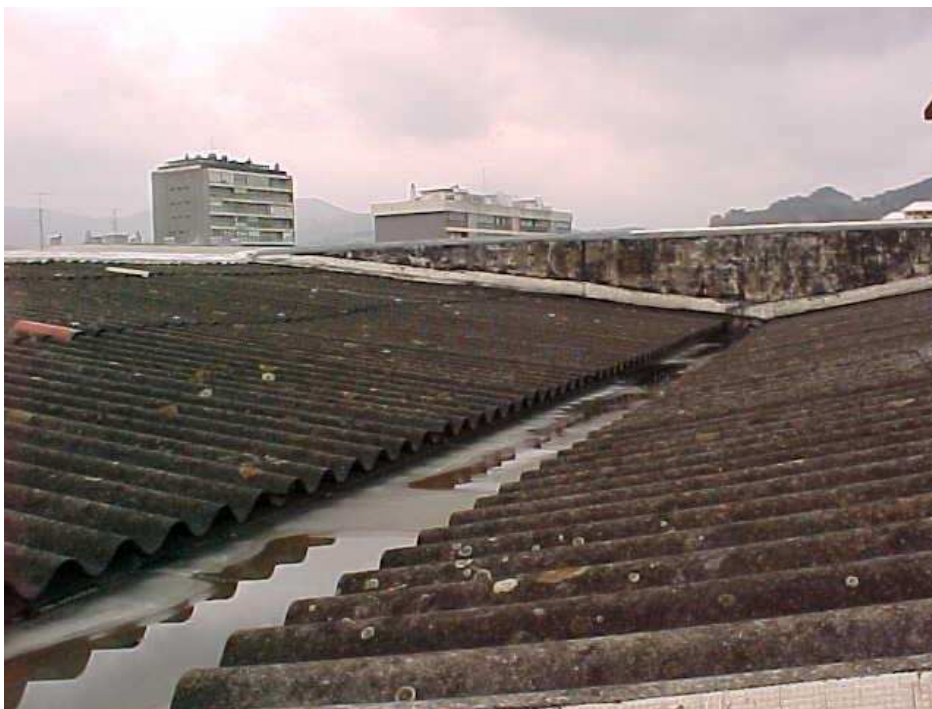
Placa Granonda de Uralita en los faldones de cubierta del edificio de 8 viviendas en Mendilauta, 20 de Zarautz, proyectado en 1964 por Roberto Martínez Anido. Fotografía del autor.
