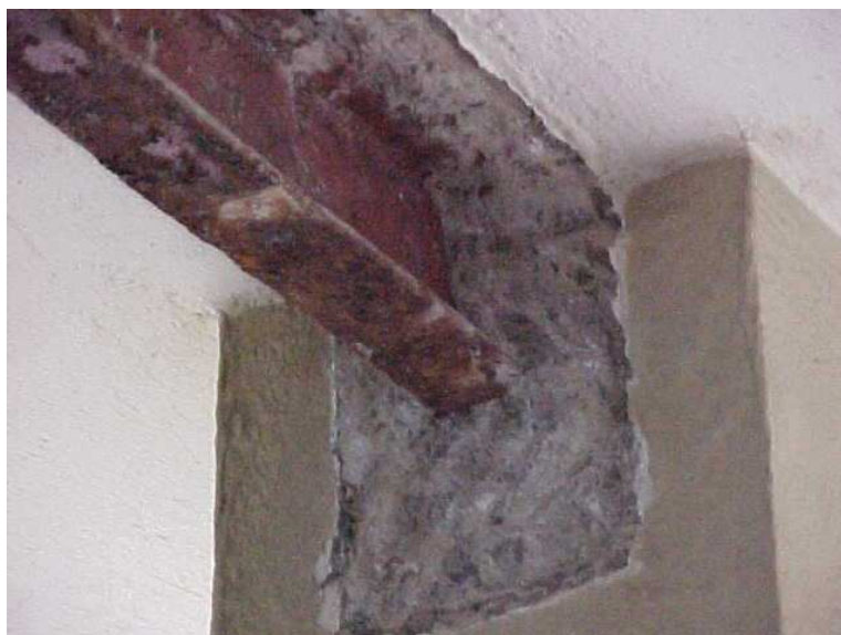
Viga de canto formada por un perfil metálico en forma de doble "T" recubierto de hormigón. Edificio de 8 viviendas situado en Zumalakarregi, 19 de Zarautz, proyectado en 1964 por Roberto Martínez Anido. Fotografía del autor.
