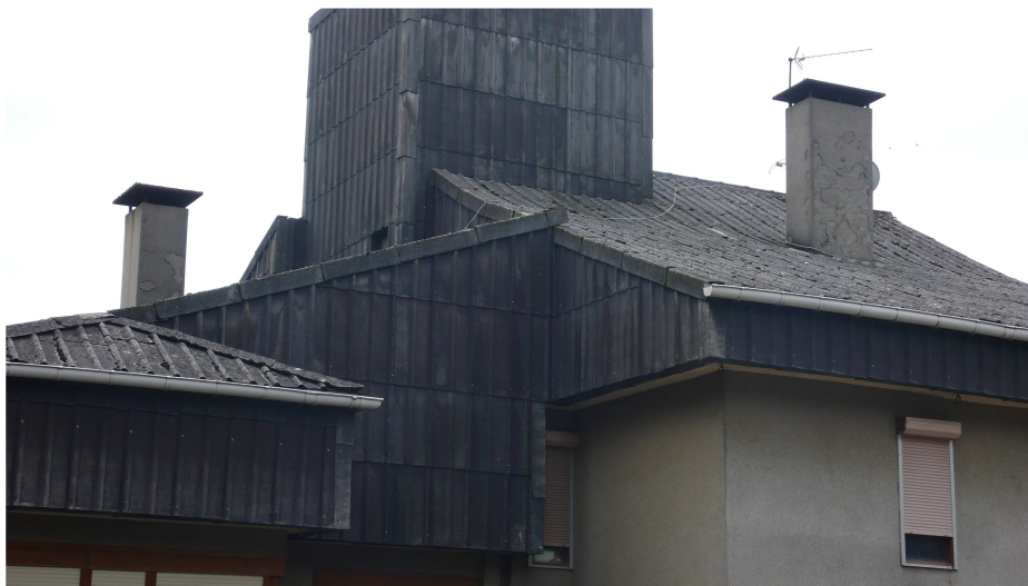
Placa Romana de Uralita en parte superior de fachada y cubierta del edificio de 9 viviendas en Makatzena, 2bis de Arrasate, proyectado en 1969 por Jesús Aldama y Antonio Aguirregoitia. Según se describe en proyecto, “Uralita color placa romana colocada con ganchos de hierro galvanizado sobre cama de rastrel de pino de 4x3” . Fotografía del autor.
