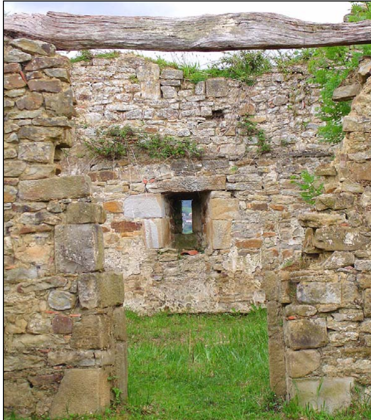
Ilustración 50: Ventanas e Intersticios Nuevas ventanas e intersticios a través de los que mirar el paisaje del Valle aparecen como posibles futuras referencias para reencontrarse connotativamente con los paisajes del Valle.
