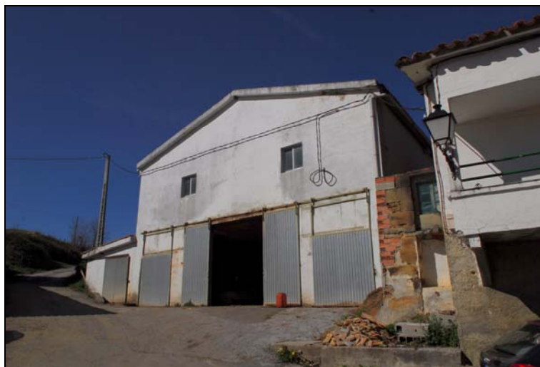
Ilustración 52: Nave estabuladora en Bernales Explotación de vacuno de leche a la entrada del barrio de Bernales. Los animales han salido de la casa pero todavía se encuentran en el mismo núcleo urbano.
