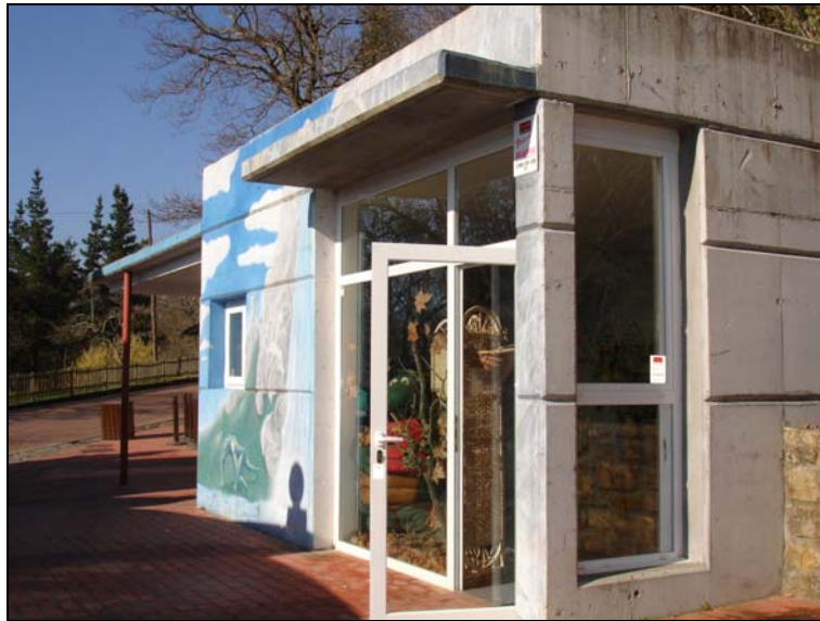
Ilustración 62: Hormigón en Karpin Abentura Los modernos cubículos de hormigón a la entrada del parque contrastan con la arquitectura indiana del resto de la finca. Dicha mezcla se puede leer como un elemento más del collage temporal que resulta el parque.
