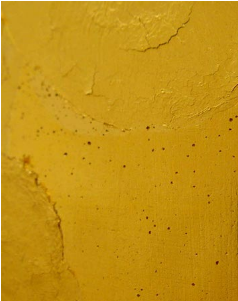
Fig. V.2.- Detalle de los cráteres que aparecen en la superficie dorada
