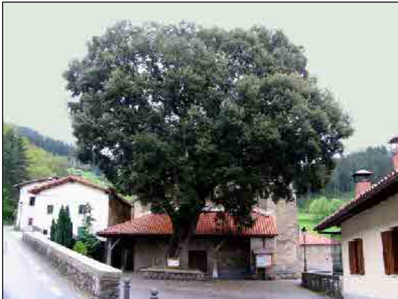
◀ Vista del inmueble. Fachada
