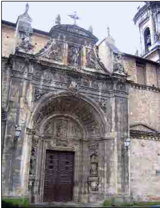
Vista del inmueble. Fachada
