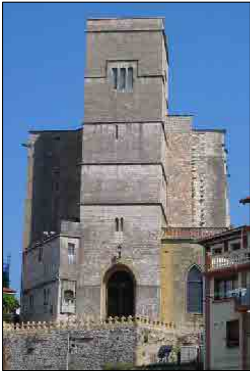
Vista del inmueble. Fachada
