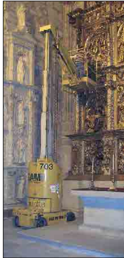
Figura 13. Estudio in situ realizado en el retablo de La Piedad (en la Parroquia de San Miguel de Oñate) con una plataforma vertical elevadora de diez metros de altura máxima de trabajo.
