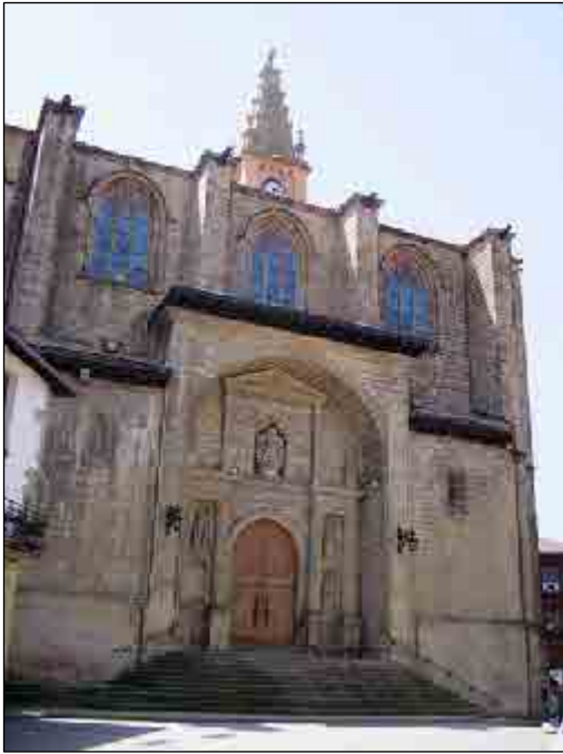
Vista del inmueble. Fachada
