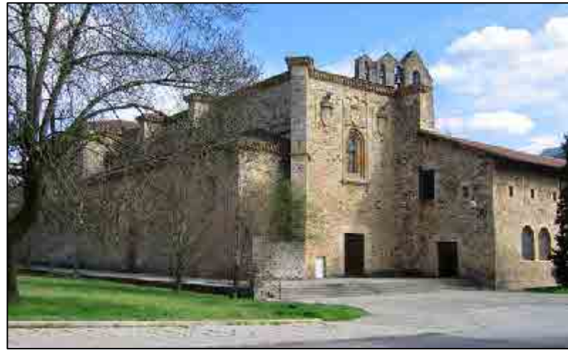
Vista del inmueble. Fachada
