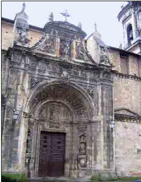
Vista del inmueble. Fachada
