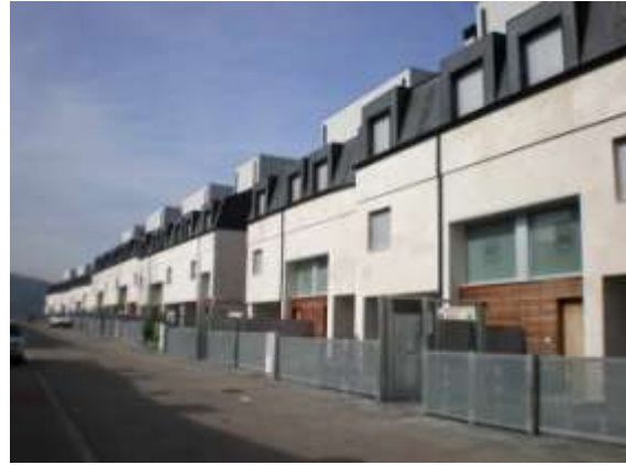
Foto 1.38. Sector Rementariñe, Derio
