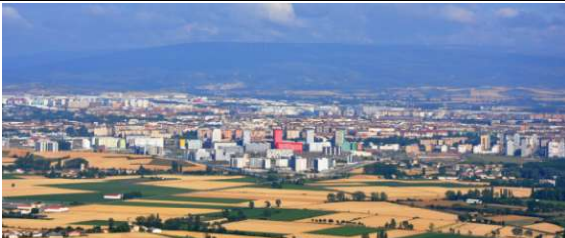
Foto 2.1. Vista panorámica del borde oriental de Vitoria-Gasteiz.
