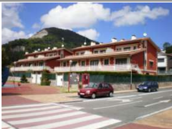
Foto 3.17. Unifamiliares seriados en Ibarra.
