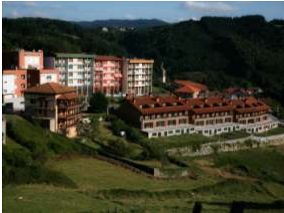
Foto 3.31. Casco urbano de Elejalde, Ibarangelu.
