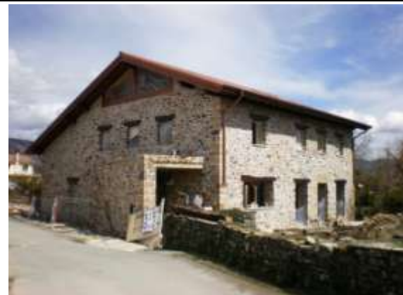
Foto 2.7. Antigua casa en rehabilitación, Ozaeta.
