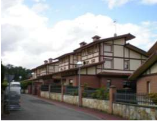
Foto 3.13. Adosados en casco urbano.
