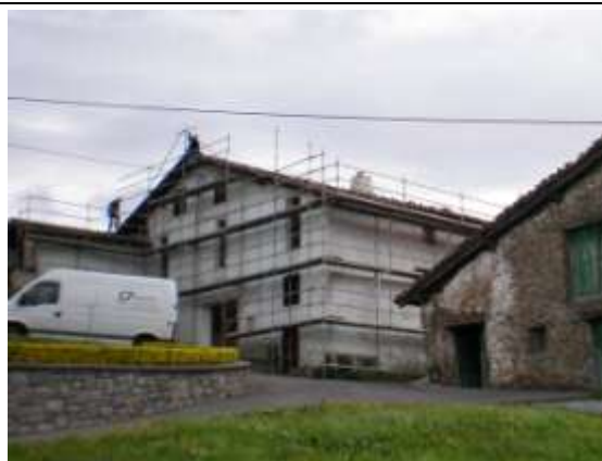
Foto 4.8. Edificio en rehabilitación, Altzagarate.
