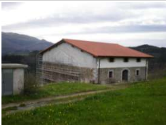
Foto 4.7. Caserío recién rehabilitado, Baliarrain.
