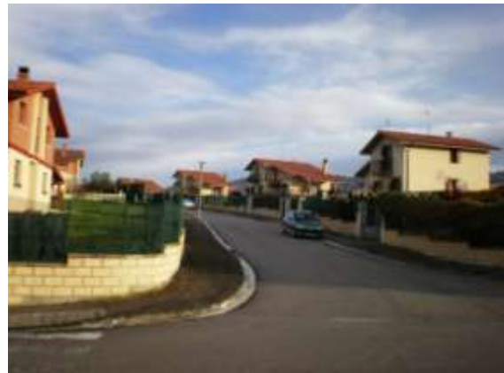
Foto 2.27 Nueva urbanización en Zaldondo.
