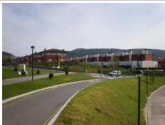
Foto 1.4. Sobreoferta de viviendas en Derio.
