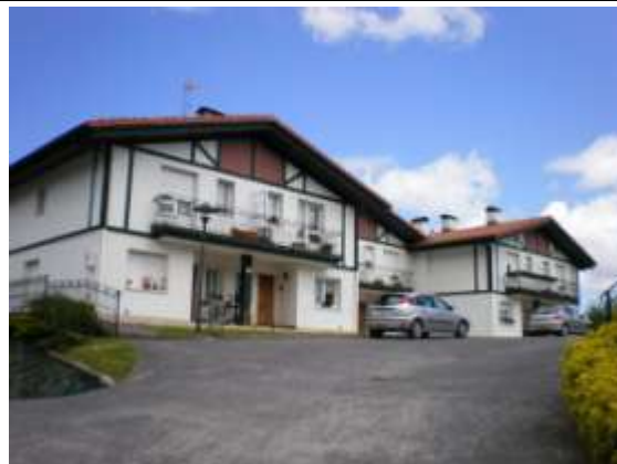
Foto 3.22. Viviendas en Elizalde, Murueta.
