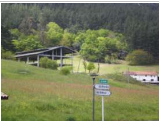
Foto 3.26. Vivienda fuera de ordenación.
