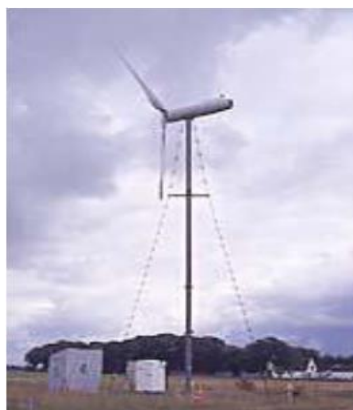
Figura 11. Torre atirantada
