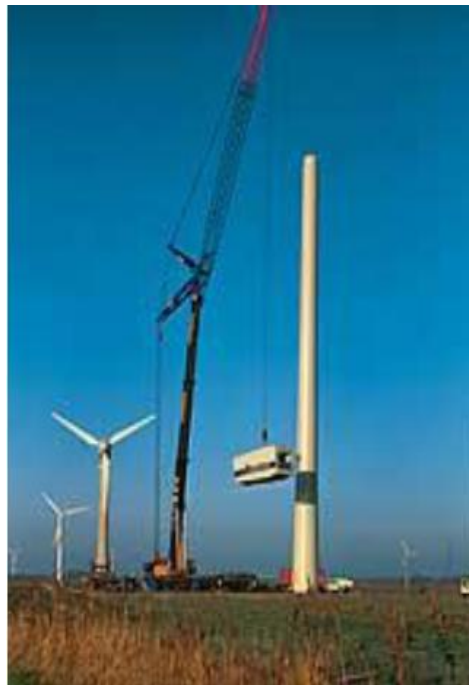
Figura 12. Torre de acero
