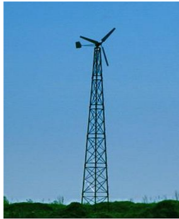
Figura 9. Torre de celosía
