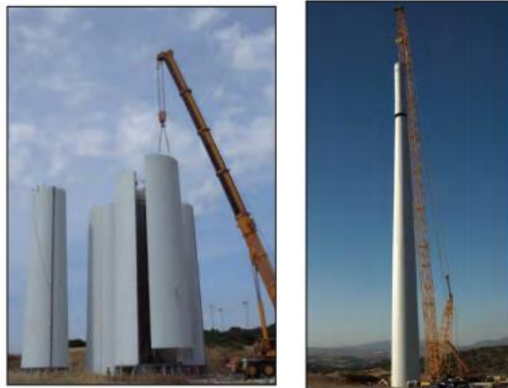
Figura 10. Torre prefabricada de hormigón
