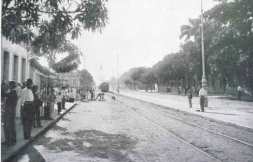
Figure 13. Felipe Fianza, Avenida Independência “tomada em frente ao mercado da V. Teta” (14,0 x 20,5 cm). Álbum de Belém. Pará 15 de novembro de 1902.. Acervo da Seção de Obras Raras da Fundação Cultural “Tancredo Neves”
