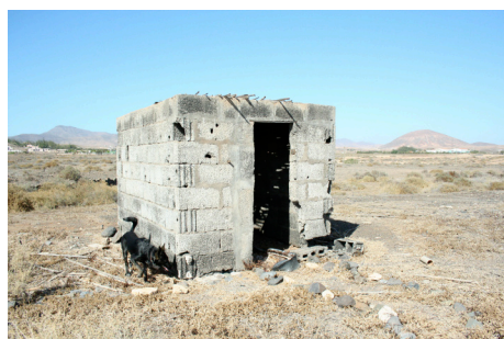
Antiguo cobertizo para guardar un depósito de agua. Empleado por los arribados como refugio de tránsito.2008.
