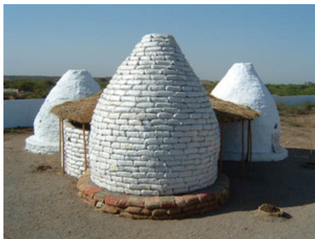
Construcción con sacos de tierra.
