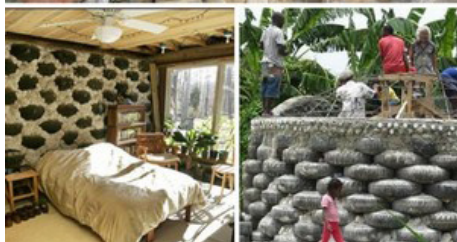
Construcción con neumáticos
