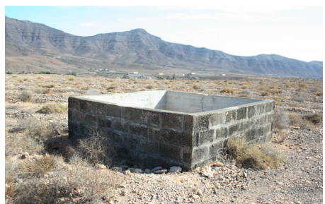
Depósito de agua vacío. Empleado como refugio de paso.
