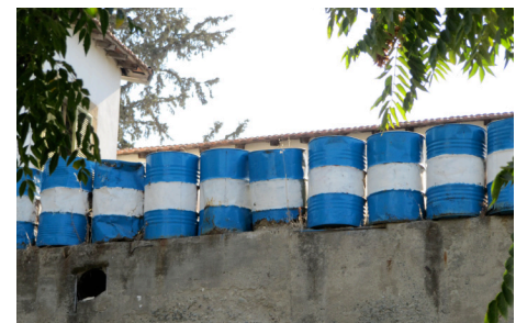
Muros y construcciones de vigilancia.Nicosia. 2013.M.Isasi
