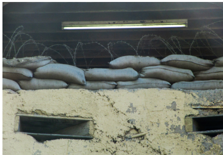
Muros y construcciones de vigilancia. Nicosia. 2013. M.Isasi
