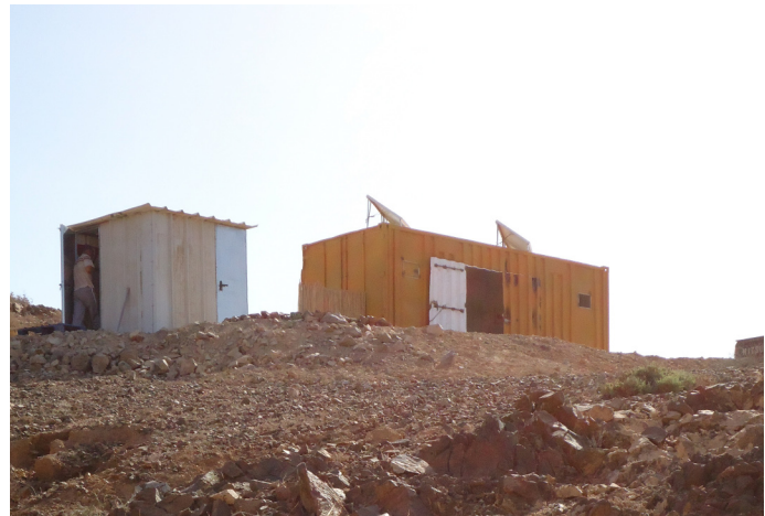
Contenedor . Nueva construcción . Fuerteventura, 2013.
