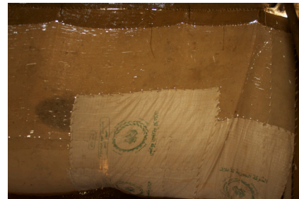
Jaima, carpa árabe (interior). Pared exterior (sacos de rafia cosidos). Siria, 2010. M. Isasi
