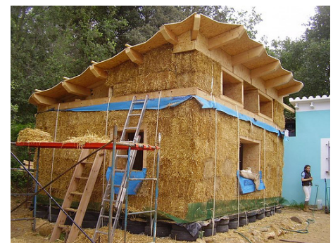
Construcción con balas de paja.
