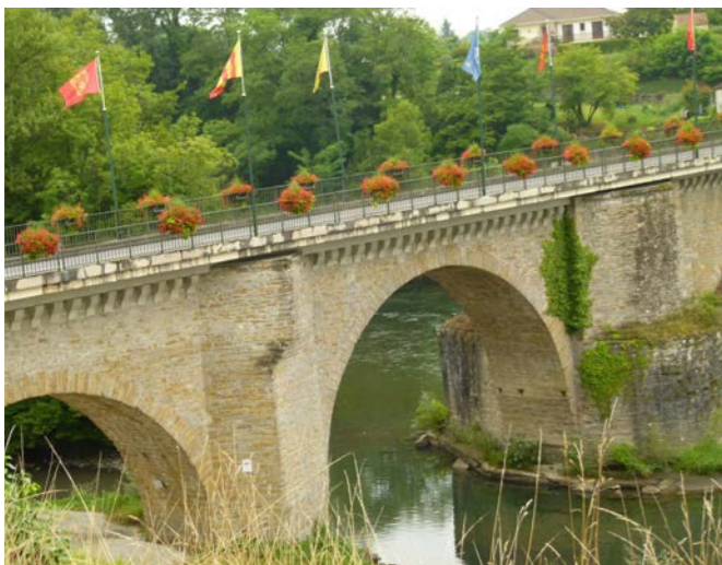
17. PUENTE SOBRE GAVE D'OLORON
