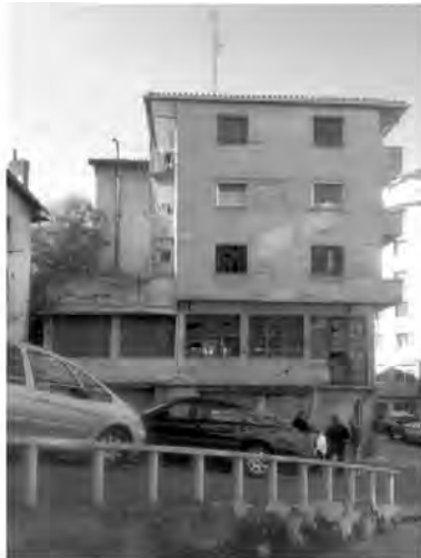
TALLERES EN UBITXA Año: 1938 Localidad: EIBAR Autor: RAIMUNDO ALBERDI Arq.
