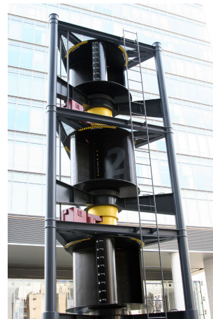
Irudia 1.18.: Savonius klasikoaren hobekuntza diseinuak.
