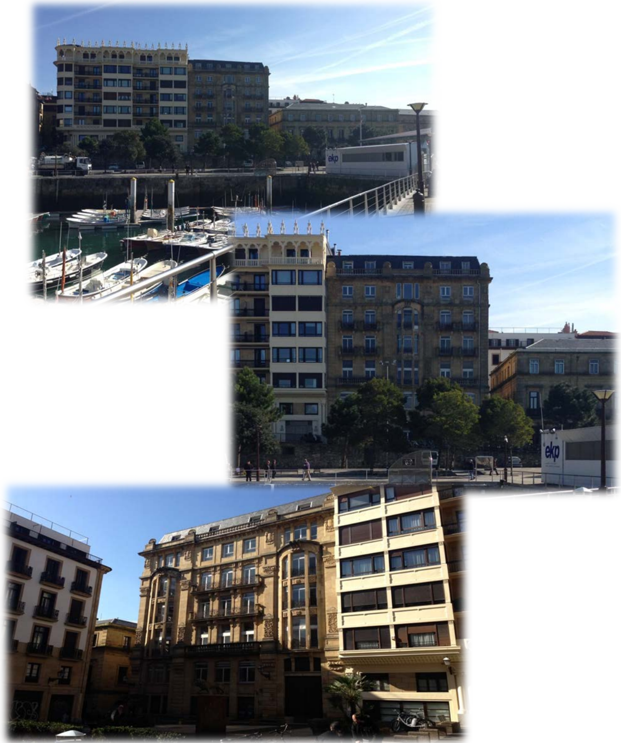
Imagen 1. Inmueble donde se pretende crear el establecimiento hotelero.
