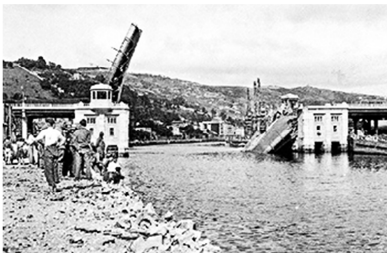
El puente de Deusto dinamitado. 1937.
