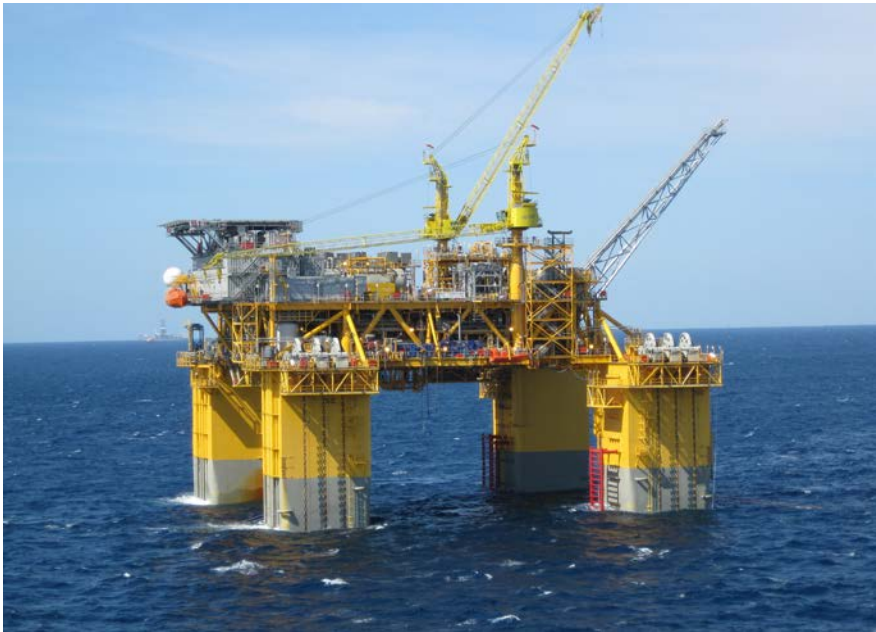
Figura 1.2 Instalación offshore Thunder-Hawk, en la que se pueden apreciar las cadenas de las líneas de anclaje (cortesía de SBM offshore).
