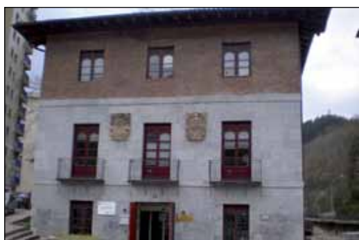
FIGURA 10 Centro de Salud de Azkoitia (Gipuzkoa)
