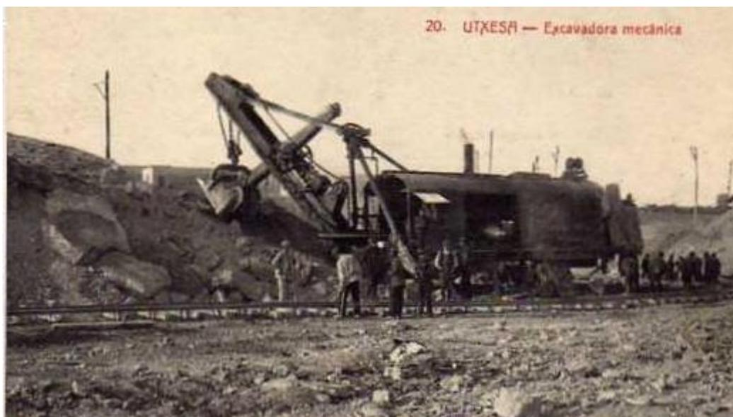
**Figura 3.4.** Excavadora para construcción de ferrocarril.
