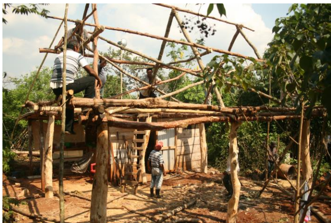
Construyendo la estructura de una tíc Santa Rosa Loma Larga, 2012
