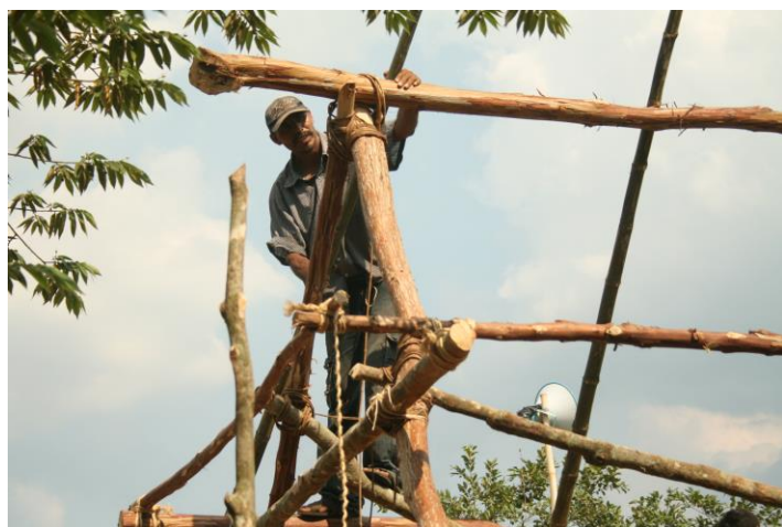
Hombre amarrando con bejucos la estructura de la tíc Santa Rosa Loma Larga, 2012
