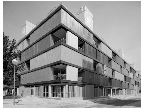
Vista del cierre de la planta baja.
