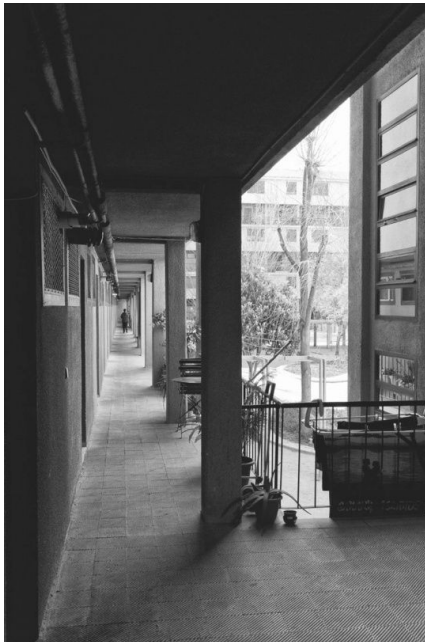
Visiones desde la galería de acceso en la casa Bloc.
