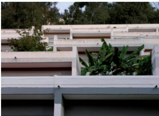
Detalle Fachada ARQYESTUDIO
