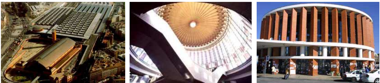
Fig. 243. Intercambiador de transporte en la Estación de Atocha en Madrid.
