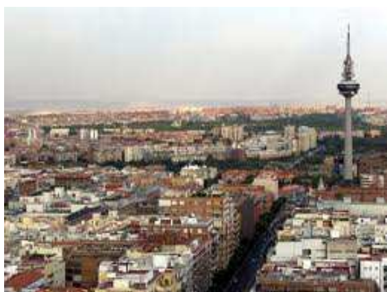
Fig. 309. Edificio Torrespaña (Madrid).
