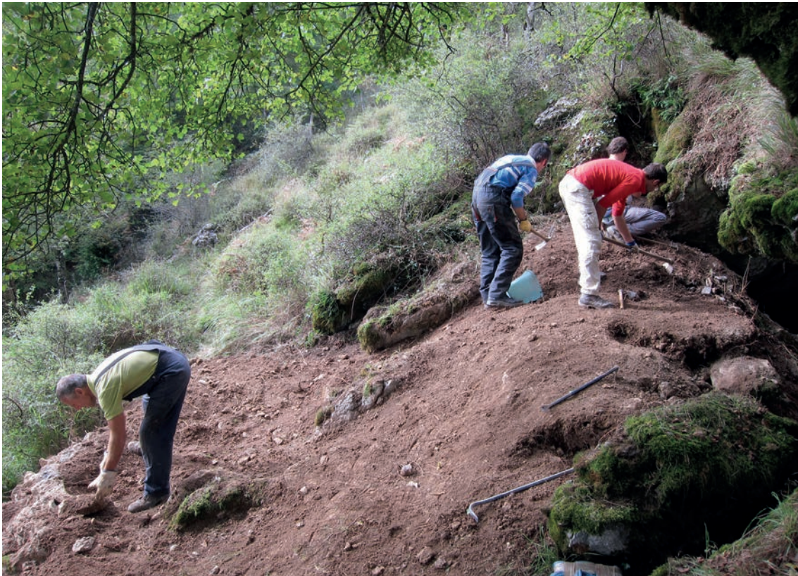
Figura 14: Labores de desmonte del parapeto de camuflaje de la cueva.
