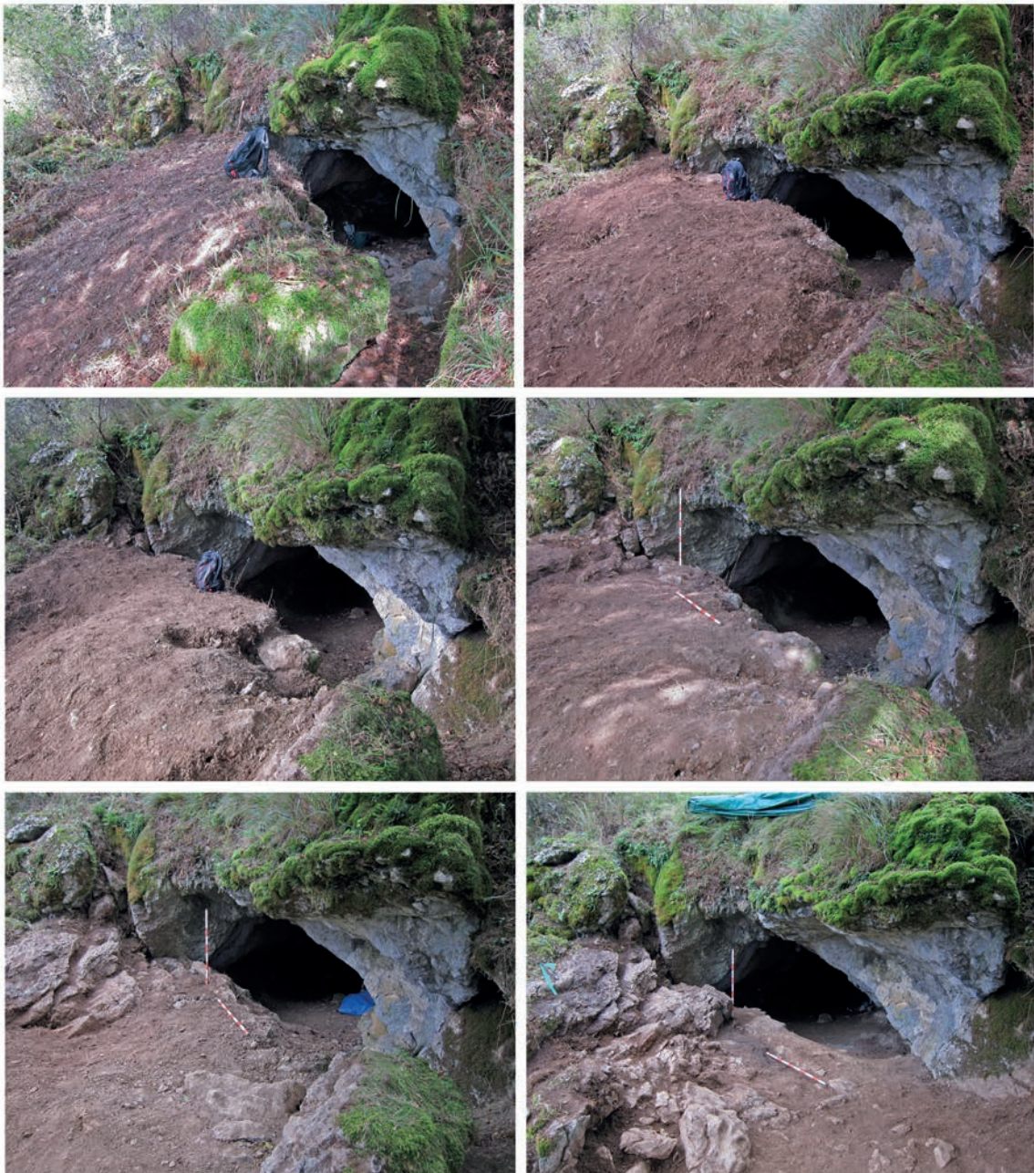
Figura 5: Montaje fotográfico con el proceso de desmonte, por tramos, del muro de camuflaje de la cavidad.
