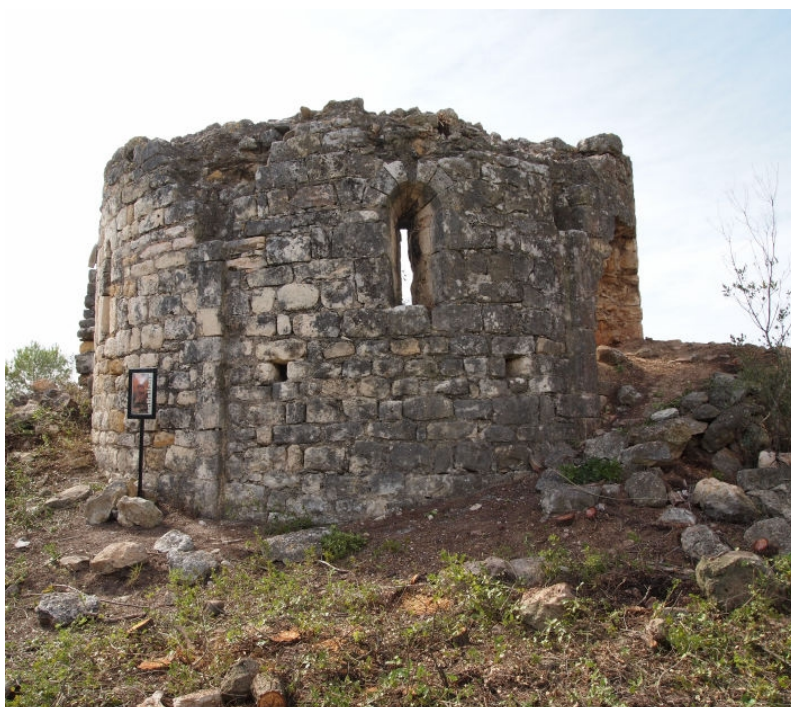
Fig. 3: Sant Llorenç de la Sanabra. Estado actual.
