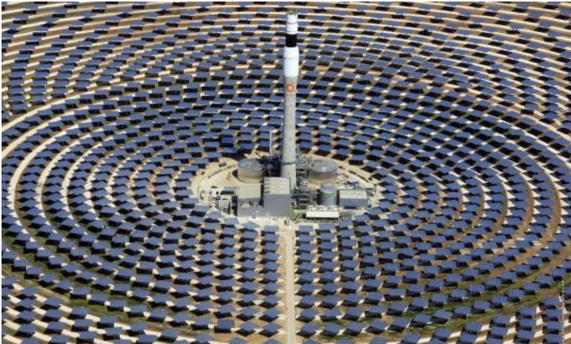
Figura 1.7: Planta de energía solar de Torresol (Torresolenergy).
