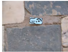
Figura 20. Toma fotográfica y señalización de puntos para georreferenciar.
