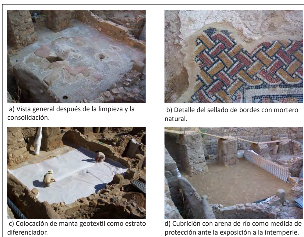
Figura 128. Mosaico encontrado en el antiguo Convento de San Andrés, proceso de conservación mediante consolidación y cubrición temporal. CCMM.
