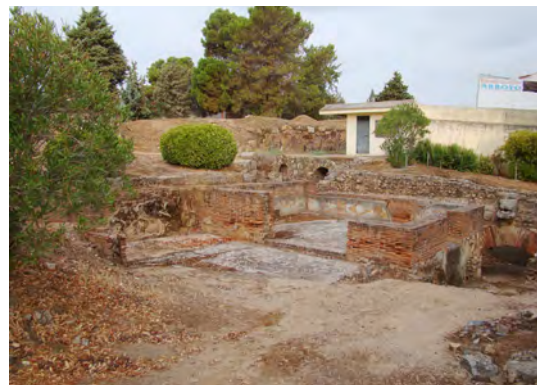
Figura 4. Casa de la Torre del agua. Vista general 2015.
