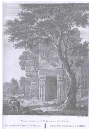
Figura 133. Aljibe según Alejandro de Laborde (vista exterior). MORÁN 2009: 393.
