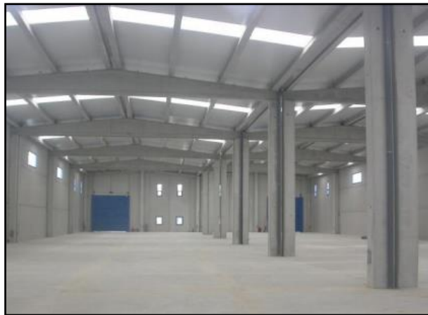
Figura 8. Estructura de hormigón prefabricado de nave industrial
