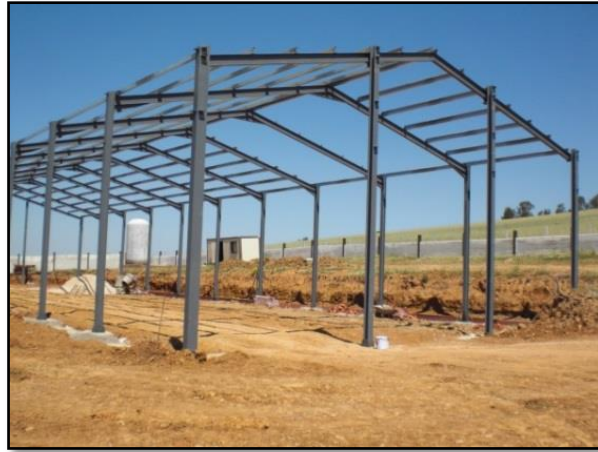
Figura 9. Estructura metálica de nave industrial
