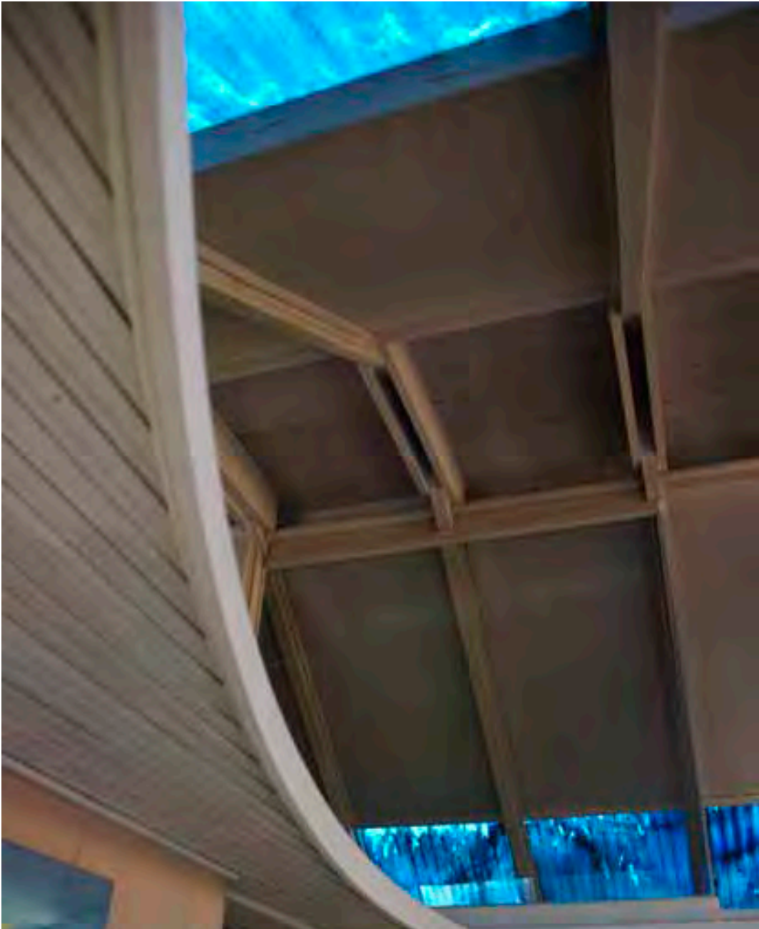
Vista interior de la cubierta de la Casa Tischler. R. M. Schindler. Los Ángeles. California. Estados Unidos. 1949
