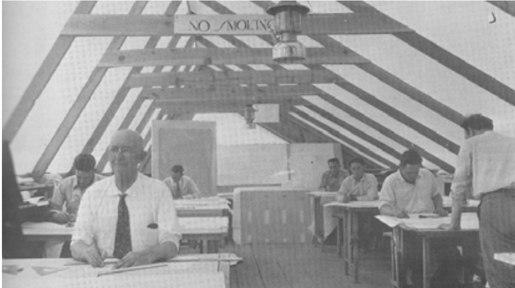
Área de trabajo en el Campamento Ocatilla. Frank Lloyd Wright. Arizona. 1928
