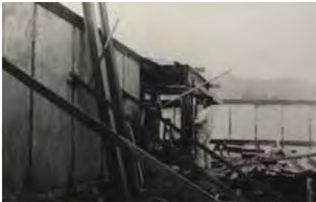
Construcción de la casa Schindler
