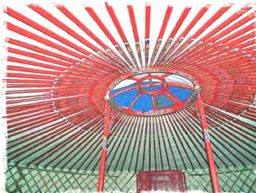
Interior de una yurta o ger . Detalle del elemento central toono .
