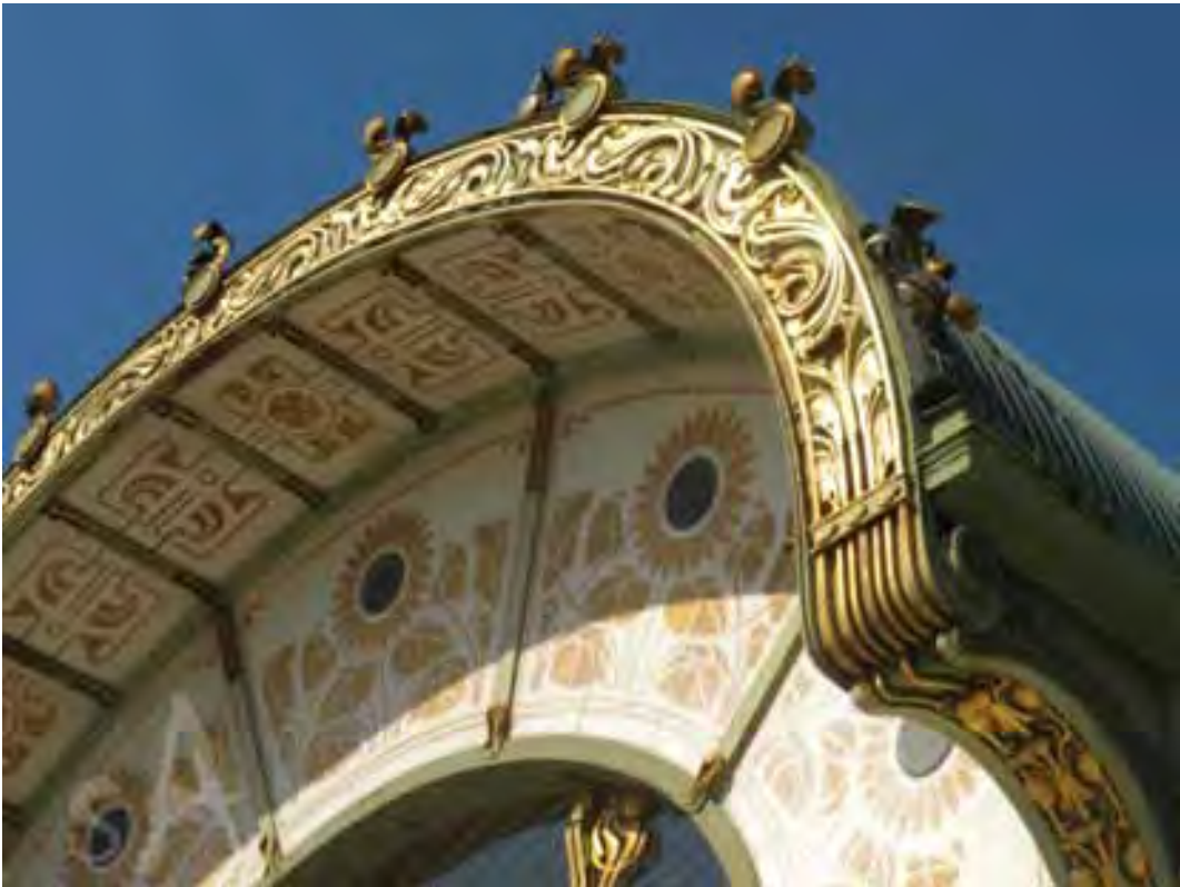
Estación de metro en Karlsplatz. Otto Wagner. Viena. 1899
