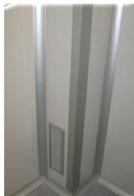
Figure 3: Paneles verticales ensamblados con uniones escocia de aluminio
