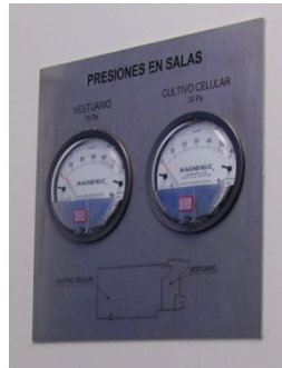
Figure 13: Manómetro en placa de acero inoxidable
