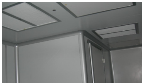
Figura 5: Paneles verticales con uniones escocia de aluminio. Techo en panel con filtro terminal.
