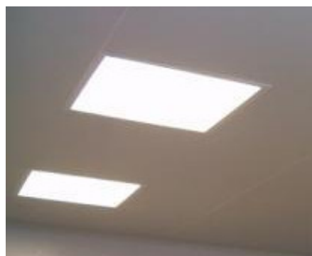
Figure 25: Caja de la luminaria encastrada en el techo formando con este un conjunto continuo y estanco.
