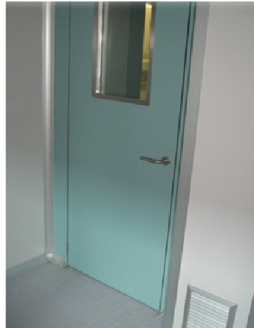
Figure 6: Puerta con panel tipo sándwich con marco y cantos en aluminio.
