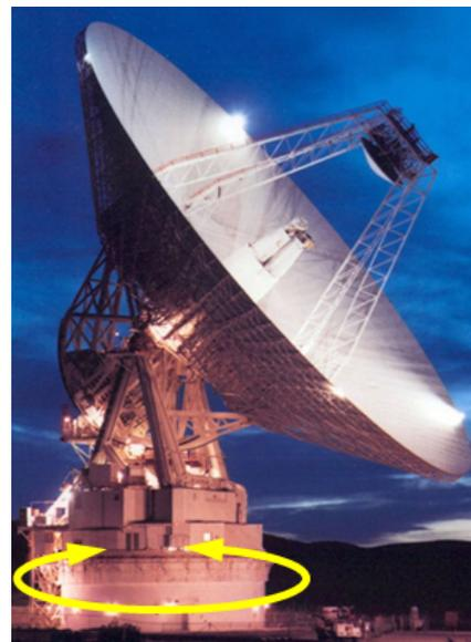
i) Rodamientos de vuelco en energía solar y antenas.
