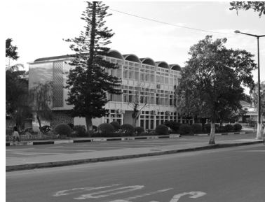
Palácio das Repartições (1960-1962)
