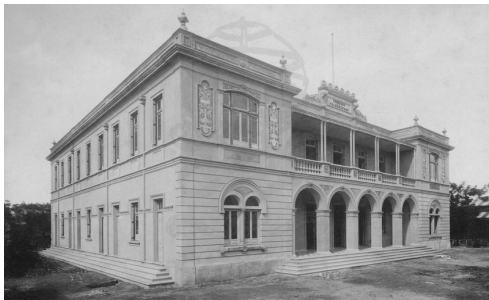
087. Edificio de Correos (1903), Maputo.
