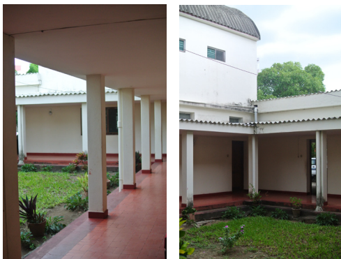
232. Paço Episcopal (1954-1957), Quelimane. Elementos de protección en el claustro norte.
