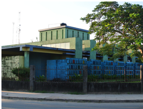
270. Biblioteca Municipal (1969), Quelimane. Vista general del conjunto.
