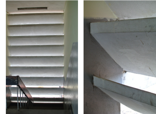
268. Liceu João de Azevedo Coutinho (1969-1970), Quelimane. Brise-soleil en el núcleo de comunicación.
