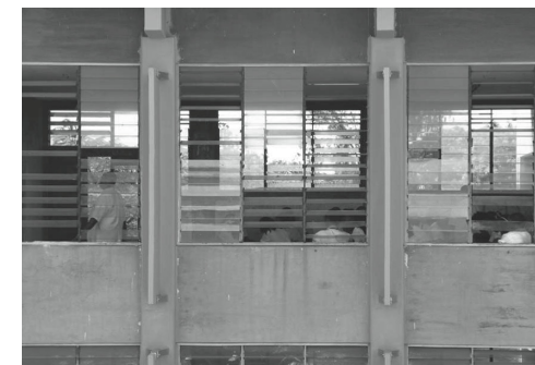
136. Escola Técnica de Nampula (1959-1973). Tratamiento de las fachadas para captación de los vientos.
