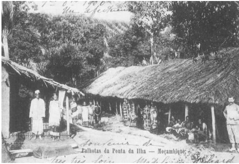
064. Viviendas tradicionales en macúti, Ilha de Moçambique.
