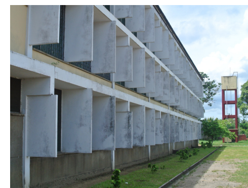
266. Liceu João de Azevedo Coutinho (1969-1970), Quelimane. Brise-soleil en el pabellón escolar.
