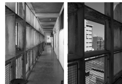
138 y 139. Conjunto Monteiro&Giro, Quelimane. Núcleo comercial, turístico y habitacional (1954-1966). Galerías de circulación y celosías.
