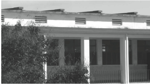
101. Liceu Nacional Salazar (1939). Cámara de aire ventilada.
