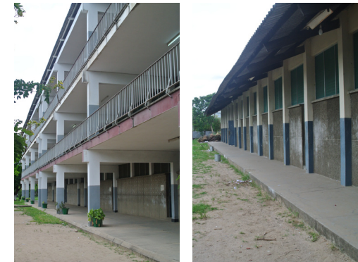
260. Liceu João de Azevedo Coutinho (1969-1970), Quelimane. Pabellón escolar y administrativo.
