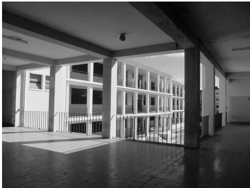
102. Liceu Nacional Salazar (1939). Galerías de circulación.
