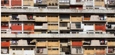
151. Edificio TAP Montepio (1955-1960), Maputo. Terrazas y salientes.
