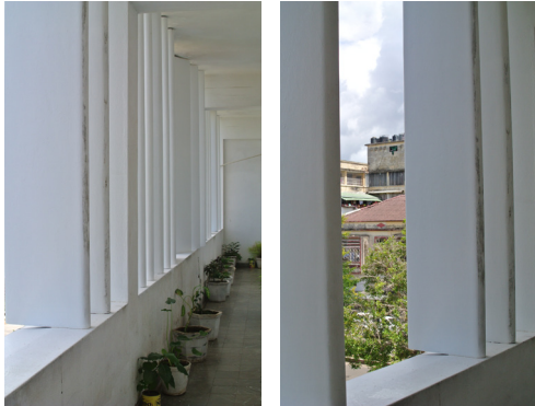
251. Palacio das Repartições (1960-1962), Quelimane. Galerías y brise-soleil.
