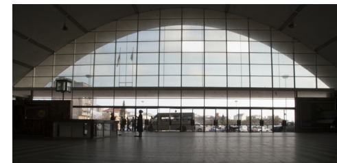
176. Estación de ferrocarriles (1958-1966), Beira. Interior del vestíbulo de acceso.
