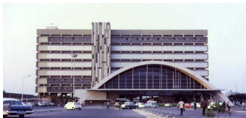
173. Estación de ferrocarriles (1958-1966), Beira. Vista general del conjunto en los años 70.
