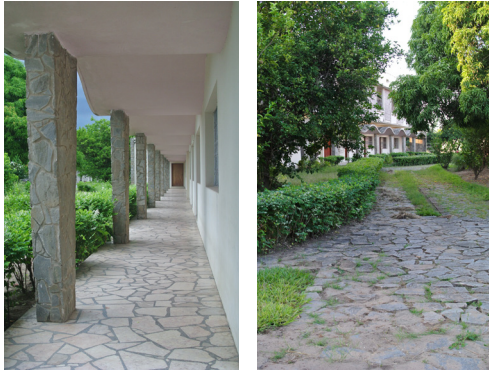
230. Paço Episcopal (1954-1957), Quelimane. Elementos de protección de la fachada principal.
