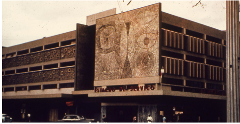
162. Edificio Abreu, Santos y Rocha (1954-1956), Maputo. Volumen original.
