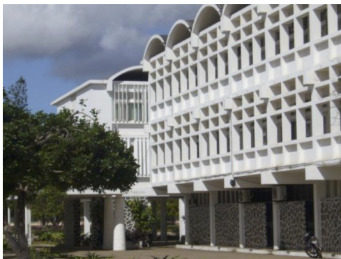
249. Palácio das Repartições (1960-1962), Quelimane. Tratamiento de la fachada noreste.
