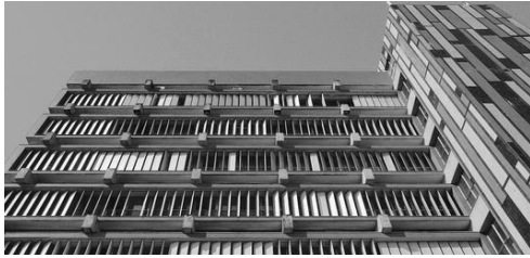
177. Estación de ferrocarriles (1958-1966), Beira. Brise-soleil en el cuerpo administrativo.
