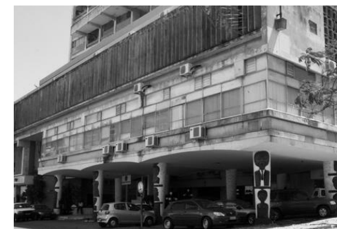
137. Edifício TAP Montepio (1955-1960), Maputo. Detalle Brise-soleil.
