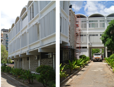
248. Palácio das Repartições (1960-1962), Quelimane. Tratamiento de las fachadas suroeste y noroeste.
