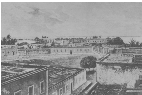
065. Arquitectura doméstica en piedra, Ilha de Moçambique.
