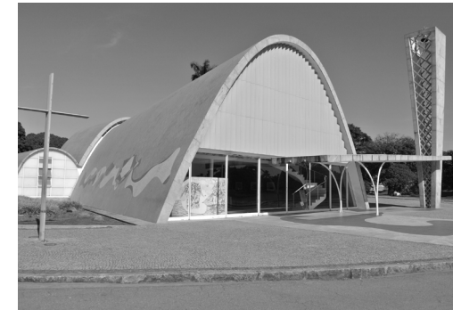
211. Igreja de São Francisco de Assís (1942), Pampulha, Belo Horizonte.
