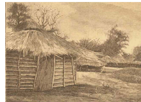
044. Técnica constructiva pau a pique . Aldea en los márgenes del río Chire.
