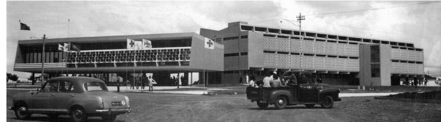
167. Palacio das Repartições (1959-1962), Lichinga. Vista del conjunto
