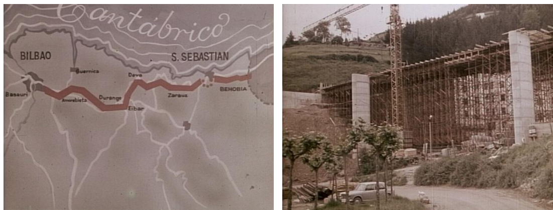
Nuevos Caminos para el País Vasco . Plano del trazado de la autopista y construcción de un viaducto para salvar la accidentada topografía.
