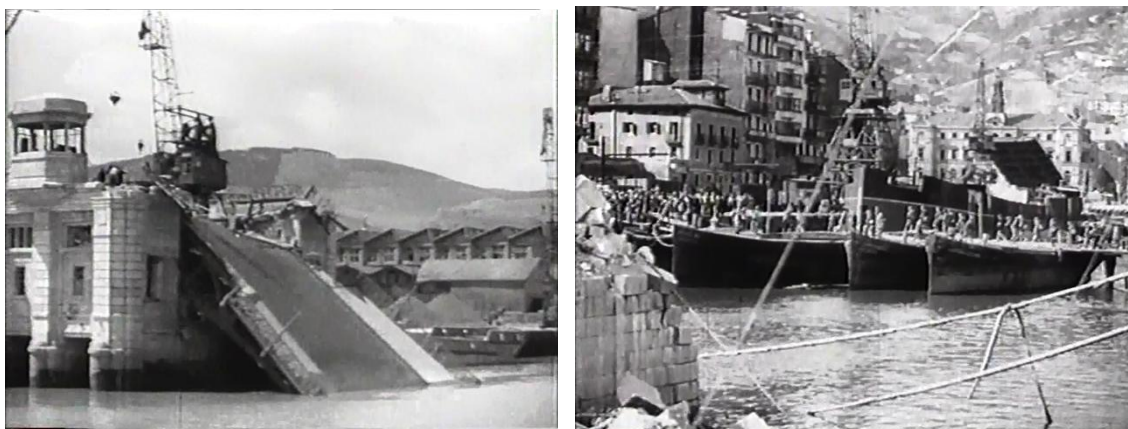
Frente de Vizcaya y 18 de Julio. Puente de Deusto destruido y puente de gabarras provisional junto al destruido puente de El Arenal.
