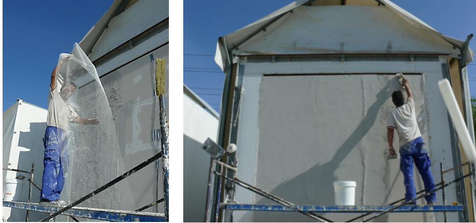
Figura 5.14 – Revestimiento final con el mortero, malla y revoco pétreo
