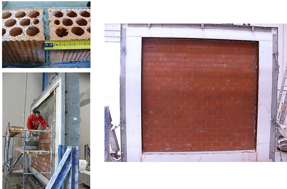
Figura 4.2 – Construcción de la hoja exterior en el portaprobetas
