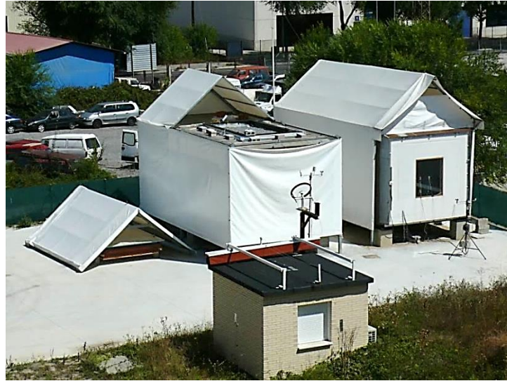
Figura 1.16 – Instalación de las celdas de ensayos PASLINK del LCCE
