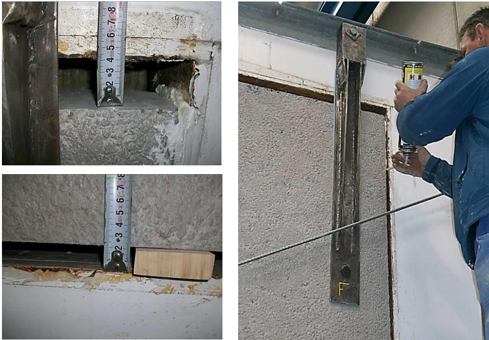
Figura 4.27 – Control espesor secciones de salida y entrada y sellado de los laterales de la placa exterior
