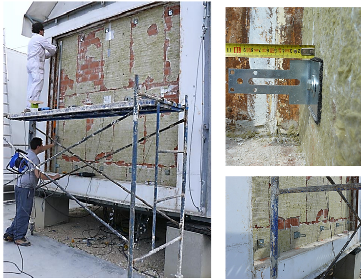
Figura 4.10 – Colocación de los anclajes puntuales sobre el muro de ladrillo
