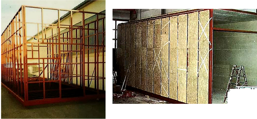
Figura 1.3 – Estructura portante y primera capa de aislamiento de lana de roca
