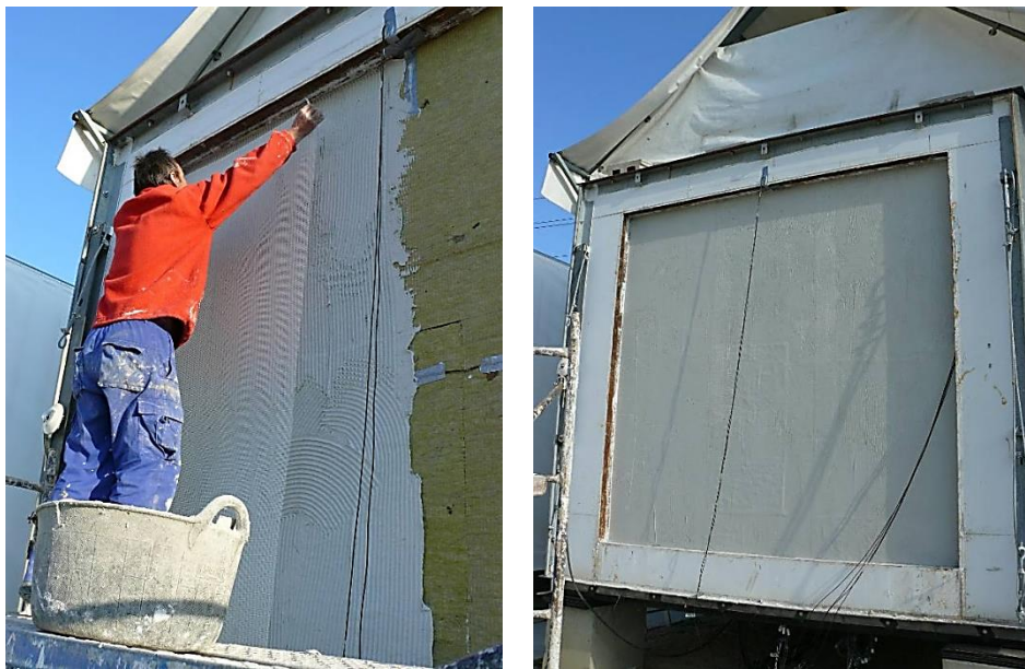
Figura 4.6 – Colocación de la malla de fibra de vidrio en el revoco de refuerzo y nivelación, imagen izquierda, y acabado final de fondo pétreo y revoco acrílico
