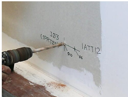
Figura 1.40 – Nomenclatura e instalación de las sondas
