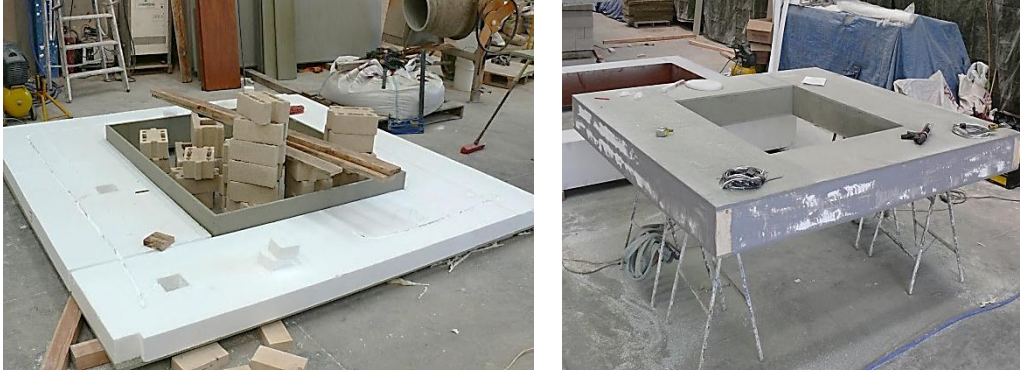
Figura 3.6 – Montaje de la parte exterior del primer componente, que sirve de base a la ventana del segundo componente
