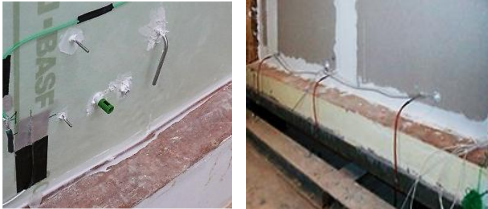
Figura 1.39 – Medida de la pérdida de carga en la cámara ventilada
