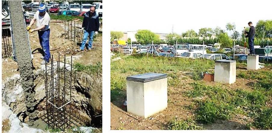
Figura 1.14 – Construcción de los cimientos y verificación de la orientación de los pilares de apoyo de la celda
