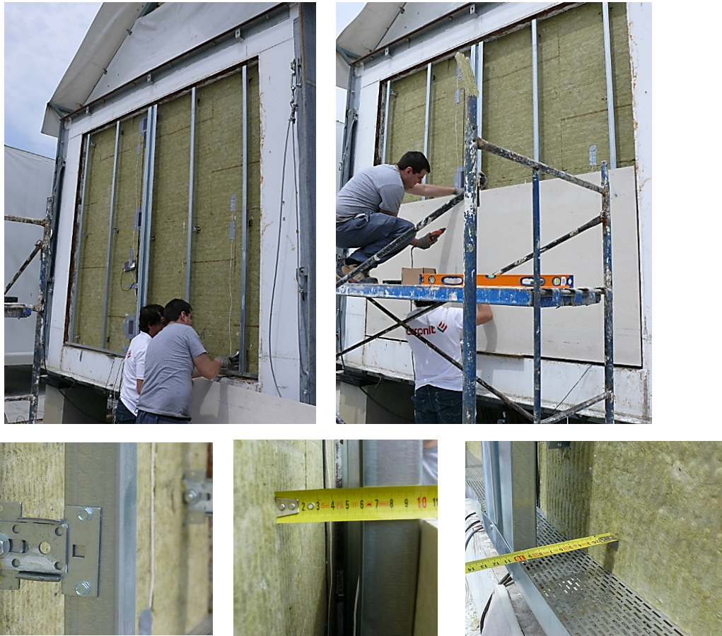
Figura 4.12 – Montaje de la hoja exterior ligera
