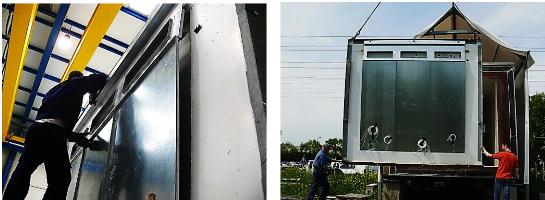
Figura 4.44 – Proceso de montaje final de la muestra de fachada forzada
