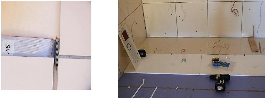
Figura 1.20 – Montaje de las HFS Tiles y detalle del sistema de conexión en serie
