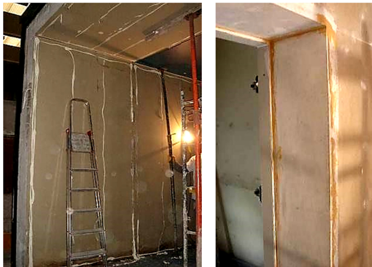
Figura 1.5 – Colocación de la primera capa de planchas de madera en la envolvente de la sala de ensayo y puerta de acceso, y detalle del sellado de juntas
