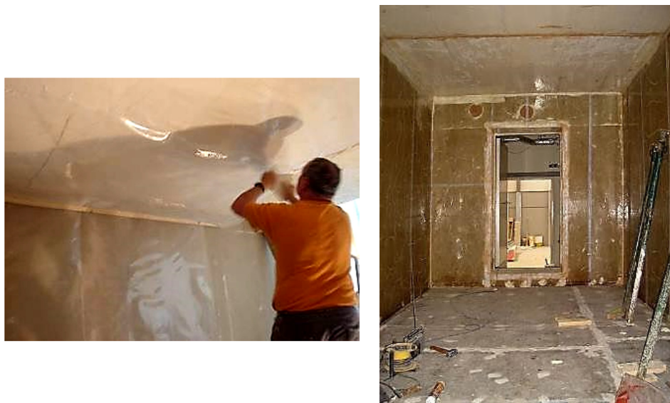
Figura 1.6 – Capa plástica para control de infiltraciones en la sala de ensayos
