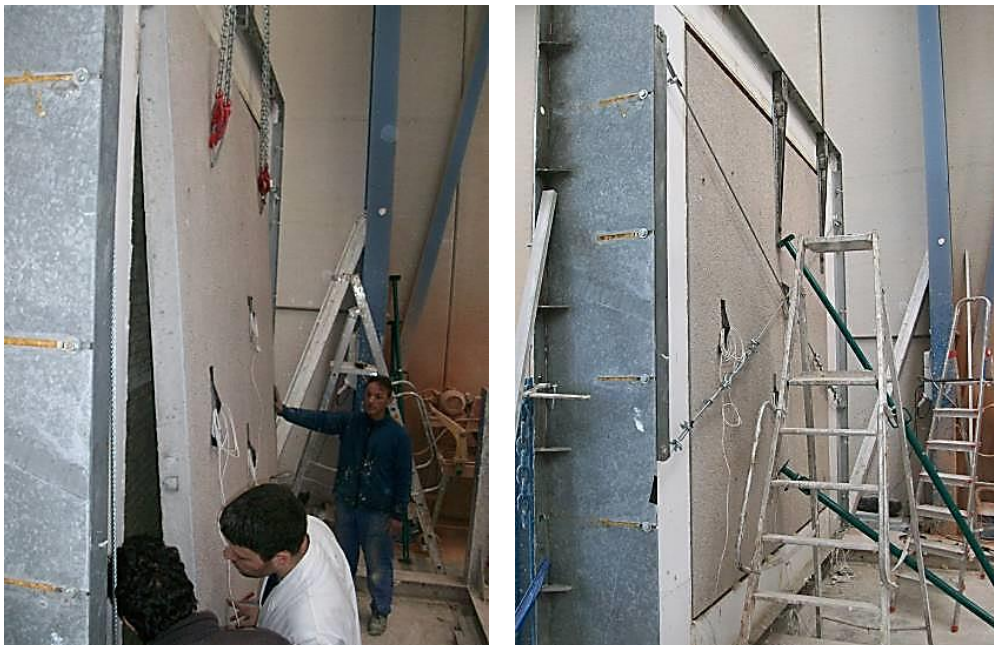
Figura 4.26 – Proceso de montaje de la hoja exterior de hormigón
