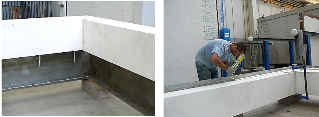
Figura 1.29 – Proceso de montaje del premarco aislante en el interior del premarco metálico y sellado de juntas
