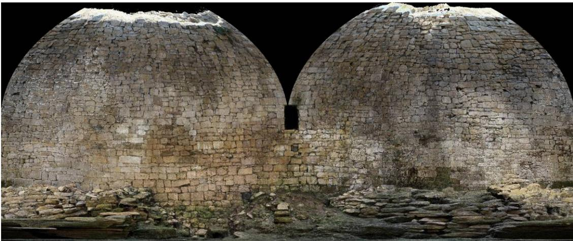
Fig. 39.- Representación plana de las paredes del pozo como combinación de un desarrollo cilíndrico y una proyección de la bóveda utilizando dos husos.
