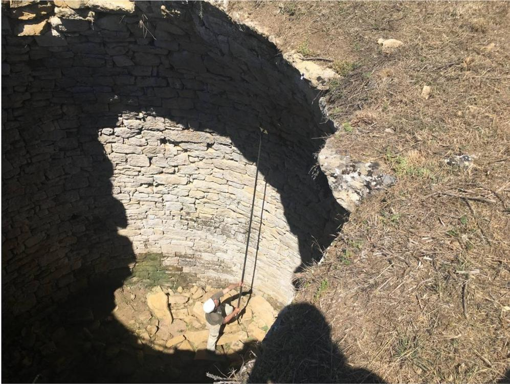
Fig. 5.-Colocación de las dianas en los niveles elevados del pozo.
