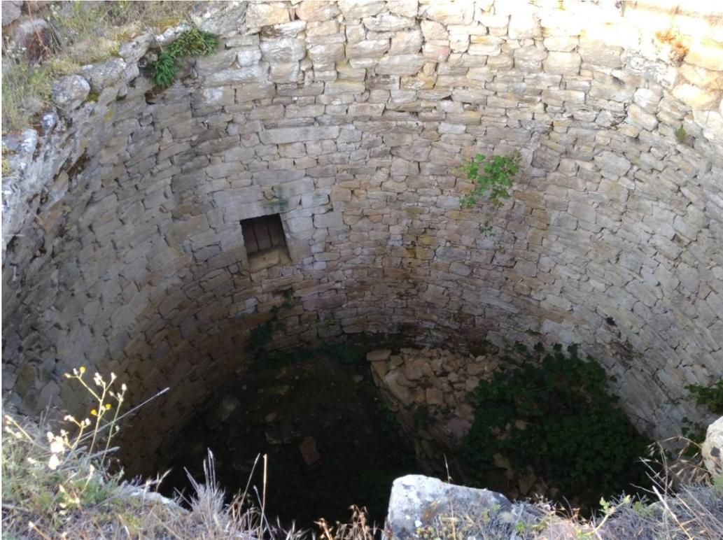
Fig. 1.- Vista del pozo de nieve desde la abertura de la parte superior. Se aprecia puerta que da acceso a la galería lateral.
