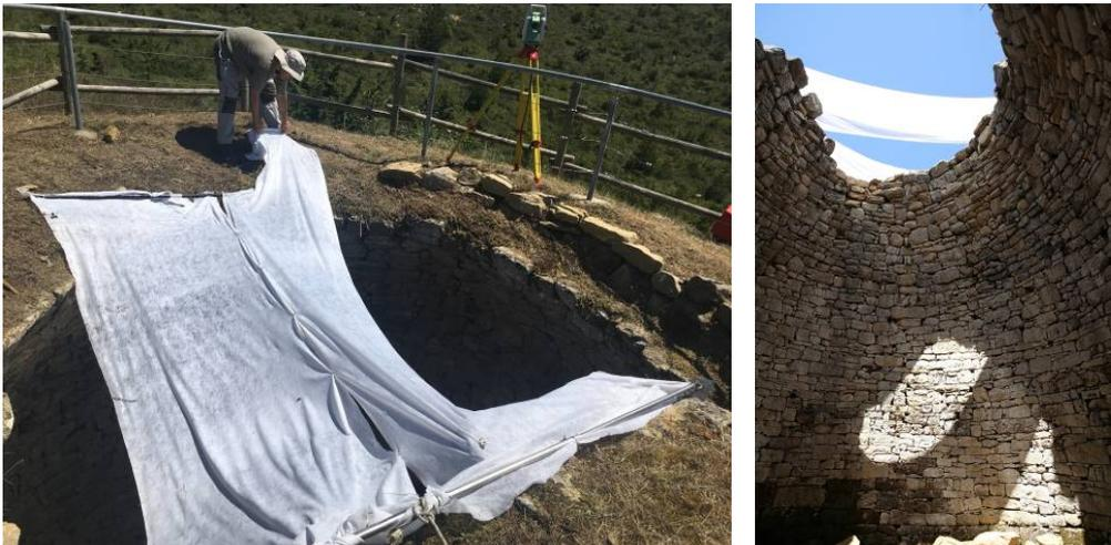
Fig.12.- Cubriendo la boca del pozo con geotextil (izquierda) y vista de cómo se atenúan las diferencias de iluminación en el interior (derecha).
