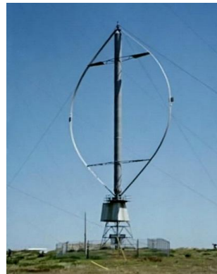
Figura 17. Rotor Darrieus
