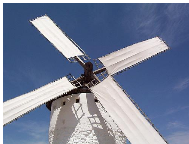
Figura 29. Aspa alabeada de madera y lonas
