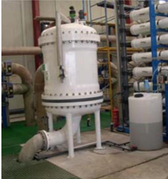
**Figura 5.19:** Cuerpo de un filtro de cartucho realizado en PRFV
