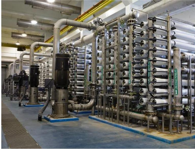
**Figura 5.28:** Bastidores de ósmosis alimentadas por bombas de alta presión
