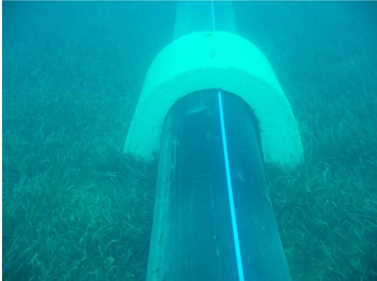
Figura 5.3: Inmisario submarino con lastre de hormigón
