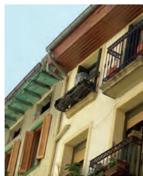
FIGURA 5. 96. ANDREKALE 40, UNIÓN DE TUBERÍA DE FECALES CON BAJANTE DE PLUVIALES EN FACHADA
