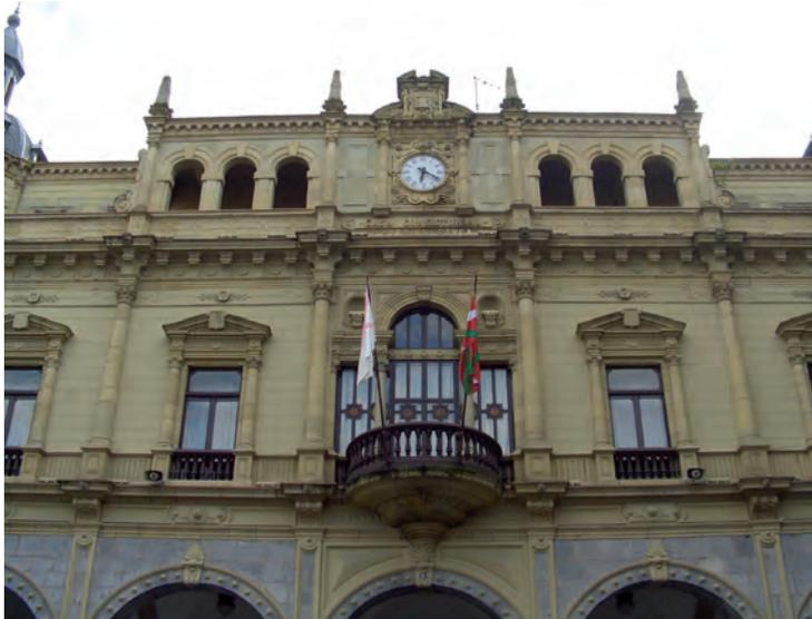
La planta superior, de construcción posterior, se mantiene retranqueada del plano de fachada, excepción hecha de los extremos, en que queda rematada por dos torreones octogonales y en la parte central, por una arquería en cuyo hueco medio se sitúa el reloj.
