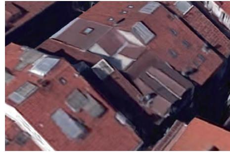
FIGURA 5. 84. KALE NAGUSIA 16, CUBIERTA A 4 AGUAS CON VENTANAS AMANSARDADAS
