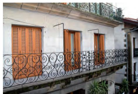
FIGURA 5. 69. KALE NAGUSIA 32, LOSA DE HORMIGÓN SOBRE MÉNSULAS DE PIEDRA
