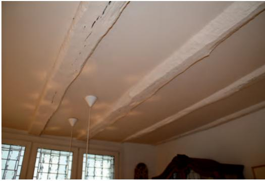
FIGURA 5. 26. ATZIETA KALEA 6, VIGUETAS APOYADAS EN FACHADA
