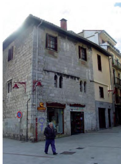
FIGURA 5. 19. ANDREKALE 46, SILLERÍA CALIZA Y DE ARENISCA JUNTO A HUECOS SUPERIORES
