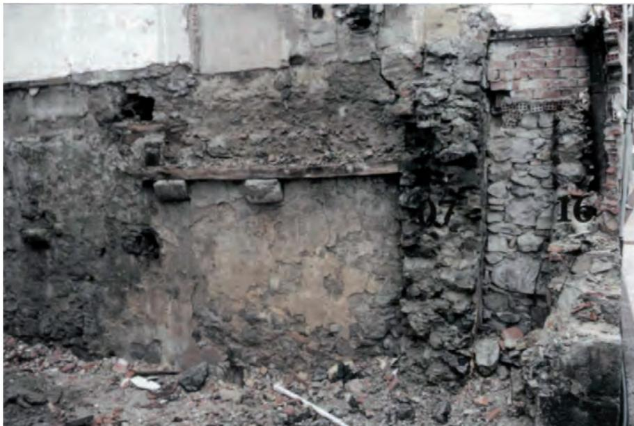
FIGURA 3.4. GUDARIEN ENPARANTZA 14. MEDIANIL CON EL Nº 13. DETALLE DE RECRECIDO DE LA FACHADA U OTROS ELEMENTOS SUSTENTANTES<sup>75</sup>
