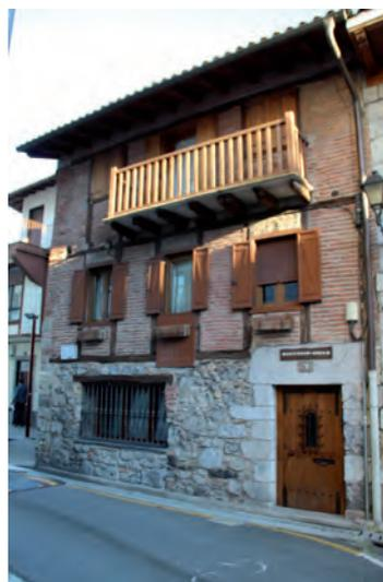
FIGURA 5. 17. ATZIETA KALEA 6, FACHADA DE MAMPOSTERÍA CALIZA Y SILLARES, Y ENTRAMADO DE MADERA CON RELLENO CERÁMICO
