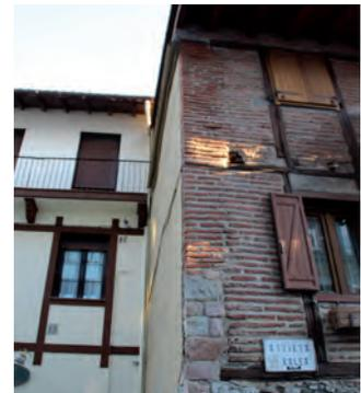
FIGURA 5. 78. ATZIETA 4. FALTA DE PLANEIDAD EN FÁBRICA
