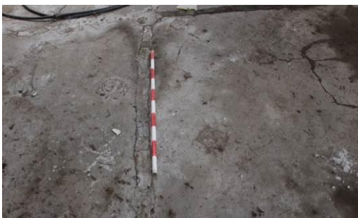
7. Irudia. 2.Zonaldea. Olio kanalizazio estaliak. Egilea: Ione Muxika Zuloaga
