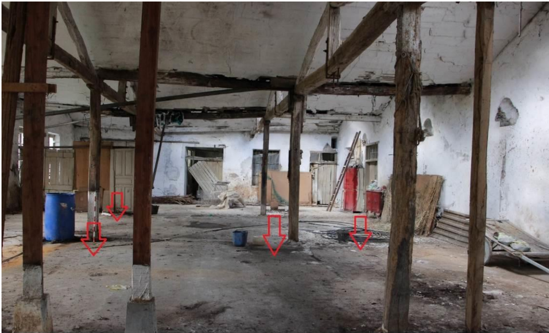
4.Eransk. 2.Zonaldea. Makinen oinarrien egiturak. Egilea: Ione Muxika Zuloaga
