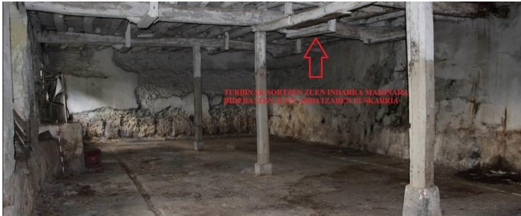
3.Eranskina1.Zonaldea. Ardatz Nagusiaren euskarri-egiturak. Egilea: Ione Muxika Zuloaga
