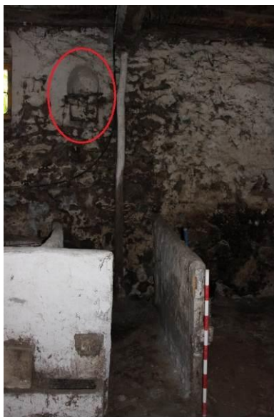
10.Irudia. Ukuilua: Ardatz Nagusiaren euskarria. Egilea: Ione Muxika Zuloaga
