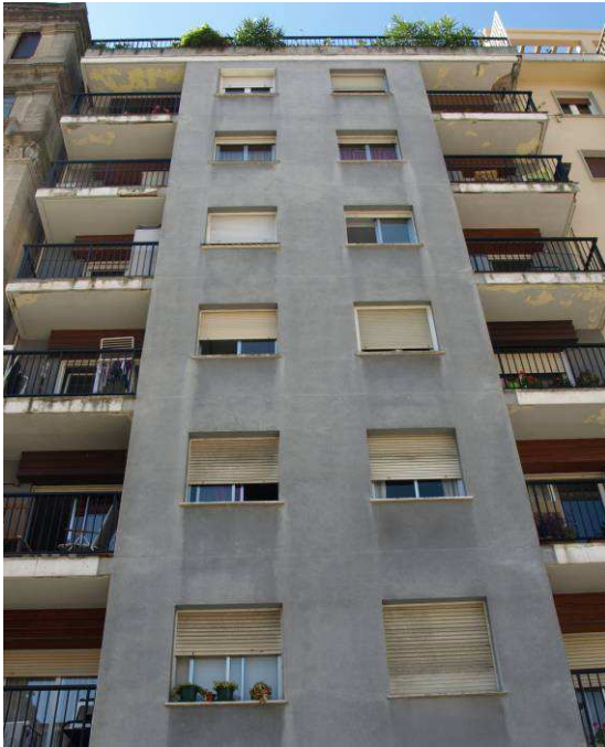
Fig. 32.12: Edificio Residencial en la Calle Trueba nº 13. Primera Etapa del Desarrollismo.
