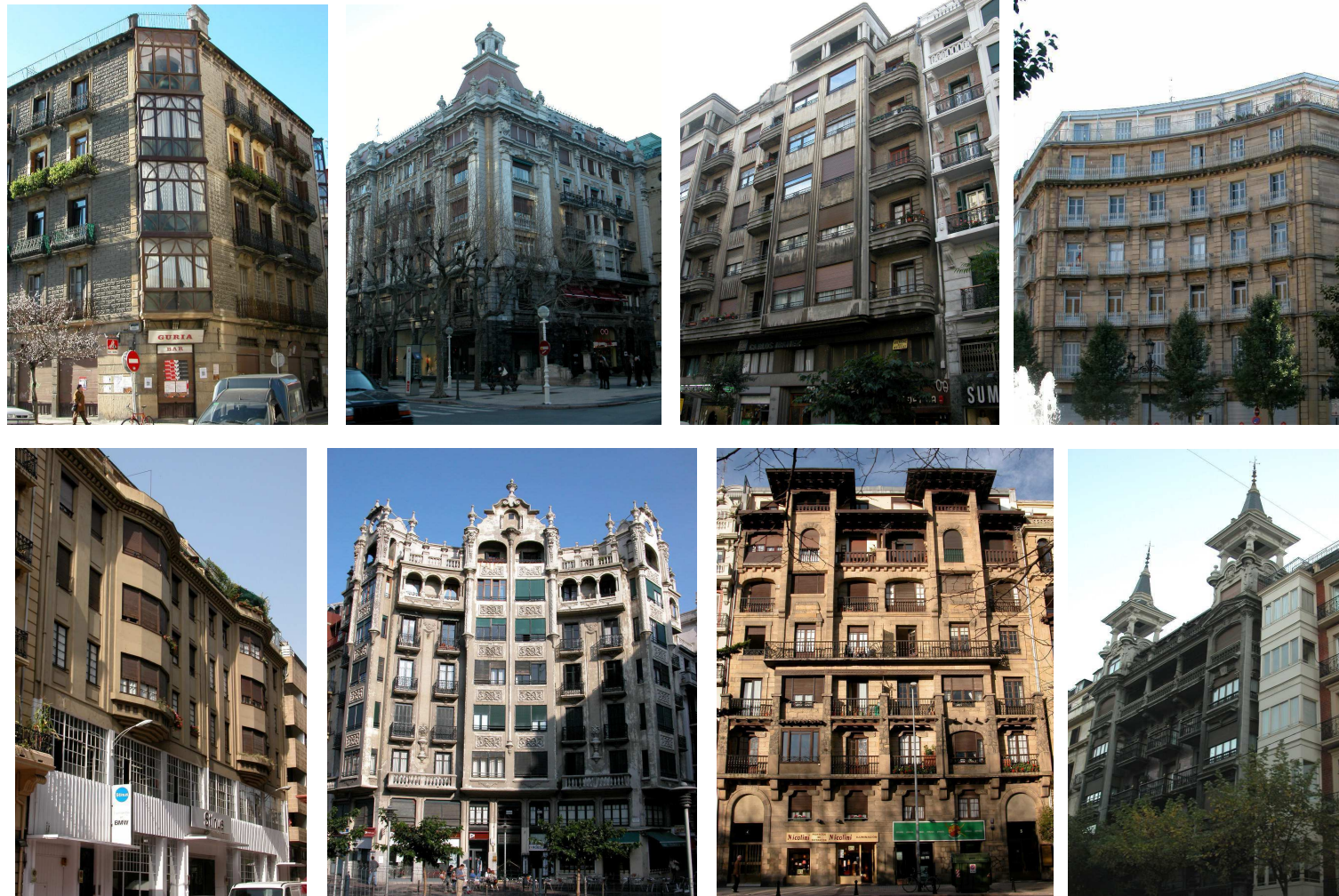
Fig. 33.14: Edificios residenciales parte del patrimonio edificado residencial de San Sebastián protegidos por el PEPPUC.
