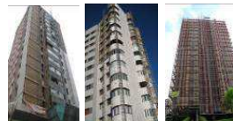
Fig. 23.23: ETXEPARE, L., Proceso de intervención energética en la Torre nº 11 del barrio de Sorgintxulo , [Fotografía], Errenteria, 2010.
