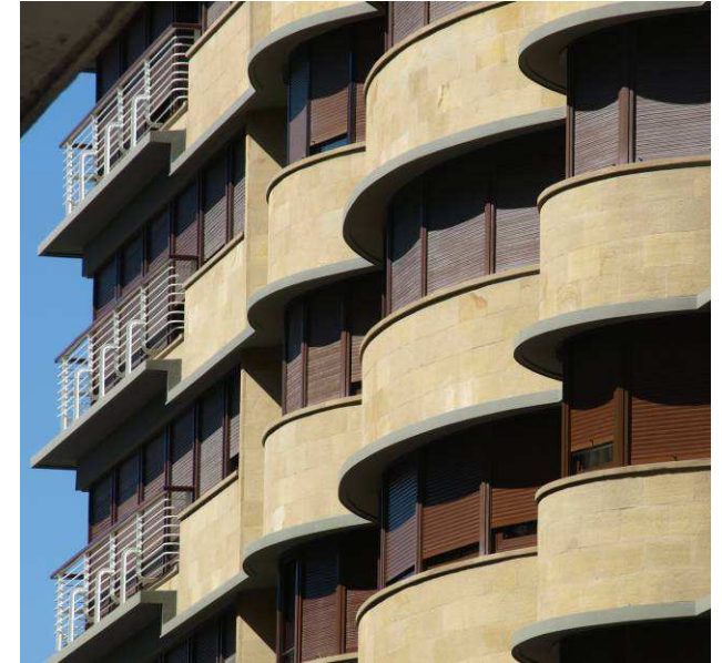
Fig. 32.13: Edificio residencial en esquina de la calles Aguirre Miramón, Ramón María Lili y Usandizaga. Arquitectos: Rafael Moneo, Javier Unzuurrungaza, Javier Marquet, Luis María Zulaica, 1970.
