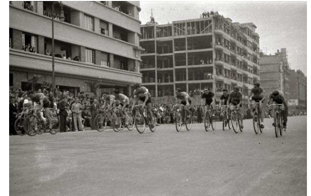
Fig. 32.45: Construcción del Estilo Racionalista. 1938-1939.
