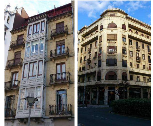
Fig. 33.24 y 33.25: Edificios protegidos y no protegidos por el PEPPUC.
