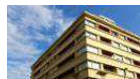
Fig. 34.04: URANGA, E.J., Fachada de estilo racionalista en el barrio de Gros , [Fotografía], Donostia, 2015.
