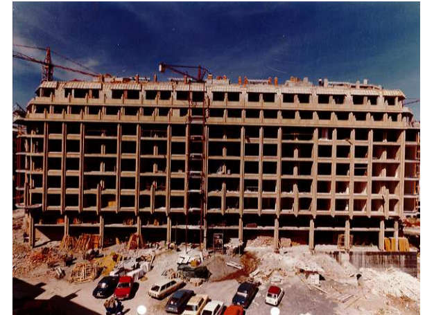
Fig. 32.54: Construcción de la Segunda Etapa del Desarrollismo. 1975.
