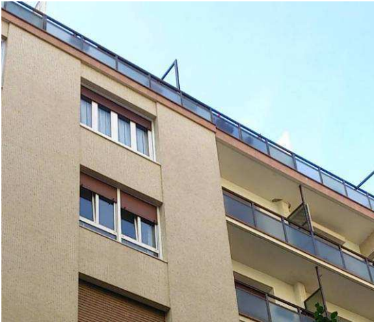
Fig. 33.58: Detalle de fachada del edificio en la calle San Francisco 42-44.
