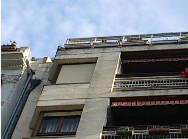
Fig. 33.64: Detalle de fachada del edificio de la calle Iztueta 1.
