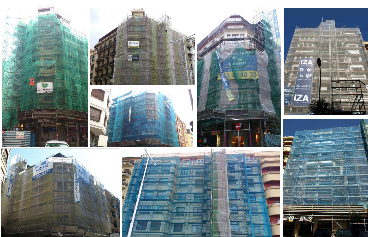
Fig. 34.02: Fachadas del barrio de Gros en proceso de intervención.
