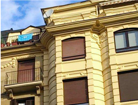
Fig. 33.40: Detalle de fachada del inmueble del Pº Colon nº 15
