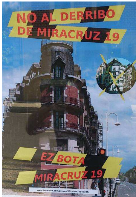
Fig. 33.23: Cartel contrario al derribo de Miracruz 19.
