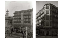
Fig. 23.30e: MARÍ, P., Edificio de viviendas de la calle San Martín en cuyos bajos se encuentra almacenes el barato , [Fotografía], 1950, Archivo Kutxa Fototeka.
