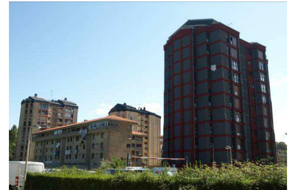
Fig. 22.73: Modificación de la imagen original de la ciudad. Polígono Arragua, Oiartzun. Gipuzkoa
