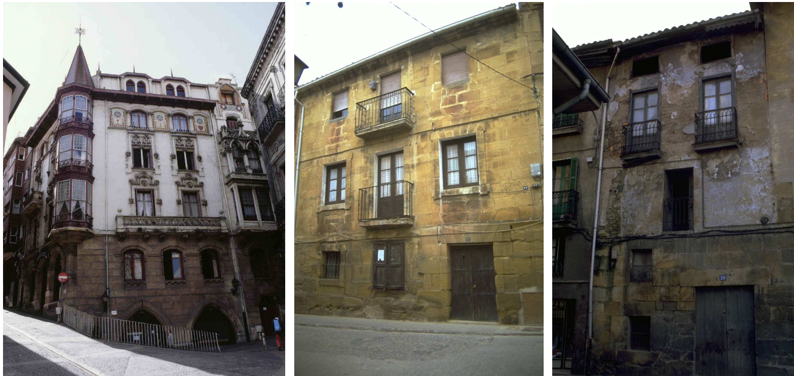
Fig. 22.42, 22.43 y 22.44: Edificios residenciales catalogados como Bienes Calificados del Patrimonio Cultural del País Vasco.
