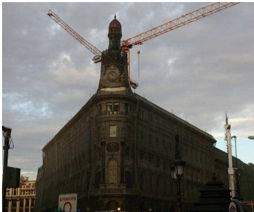
Fig. 22.15 y 22.16: Edificio Banesto. Calle Alcalá. Madrid
