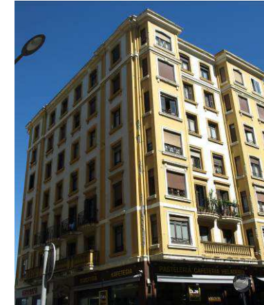
Fig. 22.59 y 22.60: Edificios residenciales históricos con necesidad de intervención. Donostia.
