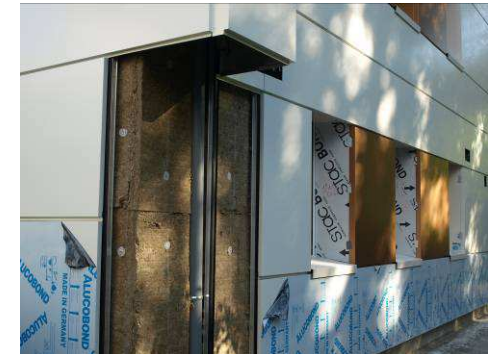
Fig. 22.55 y 22.56: Intervención energética edificio residencial.
