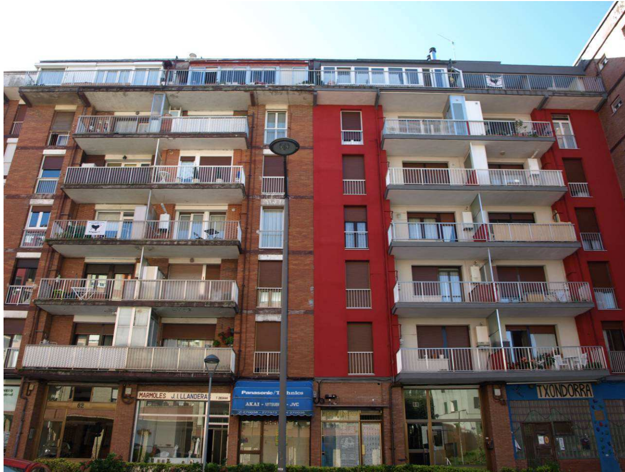
Fig. 22.83: Intervención energética en edificio de caravista con solución SATE. Barrio de Egia, Donostia.
