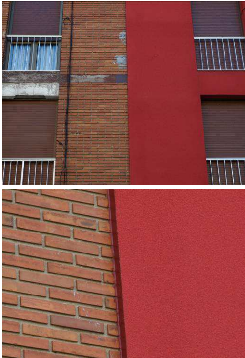
Fig. 22.90 y 22.91: Fachada tipo SATE. Barrio de Egia, Donostia.
