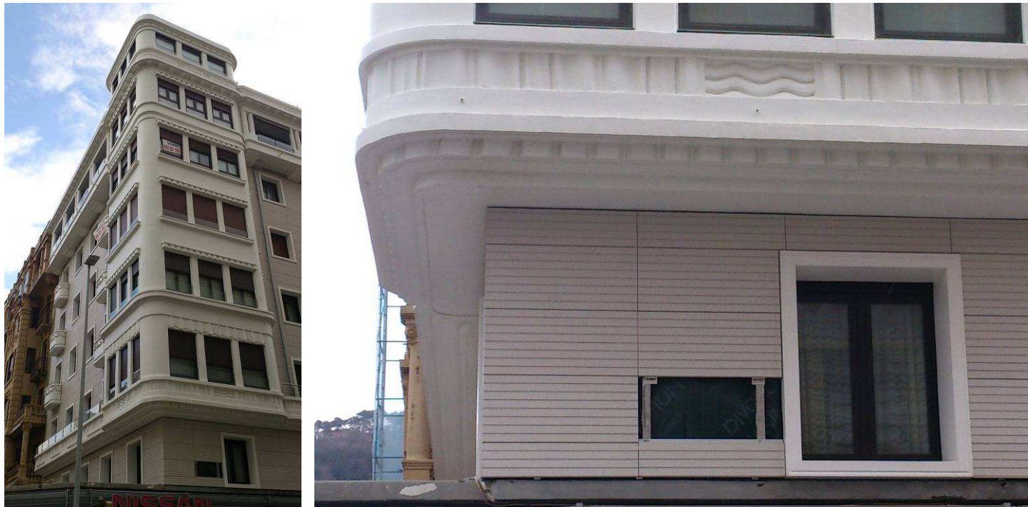
Fig. 22.49 y 22.50: Edificio residencial protegido y rehabilitado en Donostia.
