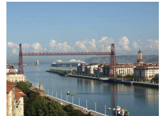
Fig. 21.41 y 21.42: Puente Colgante de Portugalete. Bizkaia.
