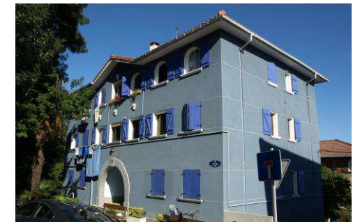
Fig. 22.57 y 22.58: Edificios con y sin protección. Donostia.
