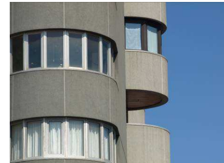
Fig. 22.77 y 22.78: Intervención energética. Alto de Kaputxinos. Errenteria, Gipuzkoa
