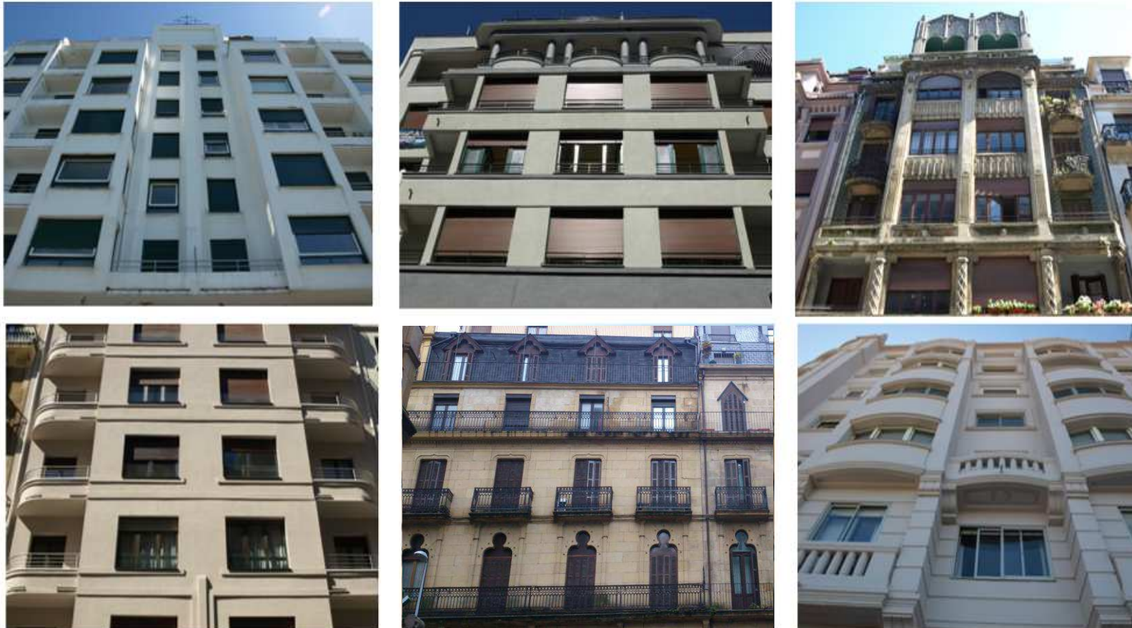
Fig. 22.97: Diversidad de fachadas de la ciudad. Barrio de Gros, Donostia.
