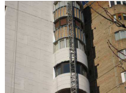
Fig. 22.07 y 22.08: Torre Kaputxinos, Errenteria.
