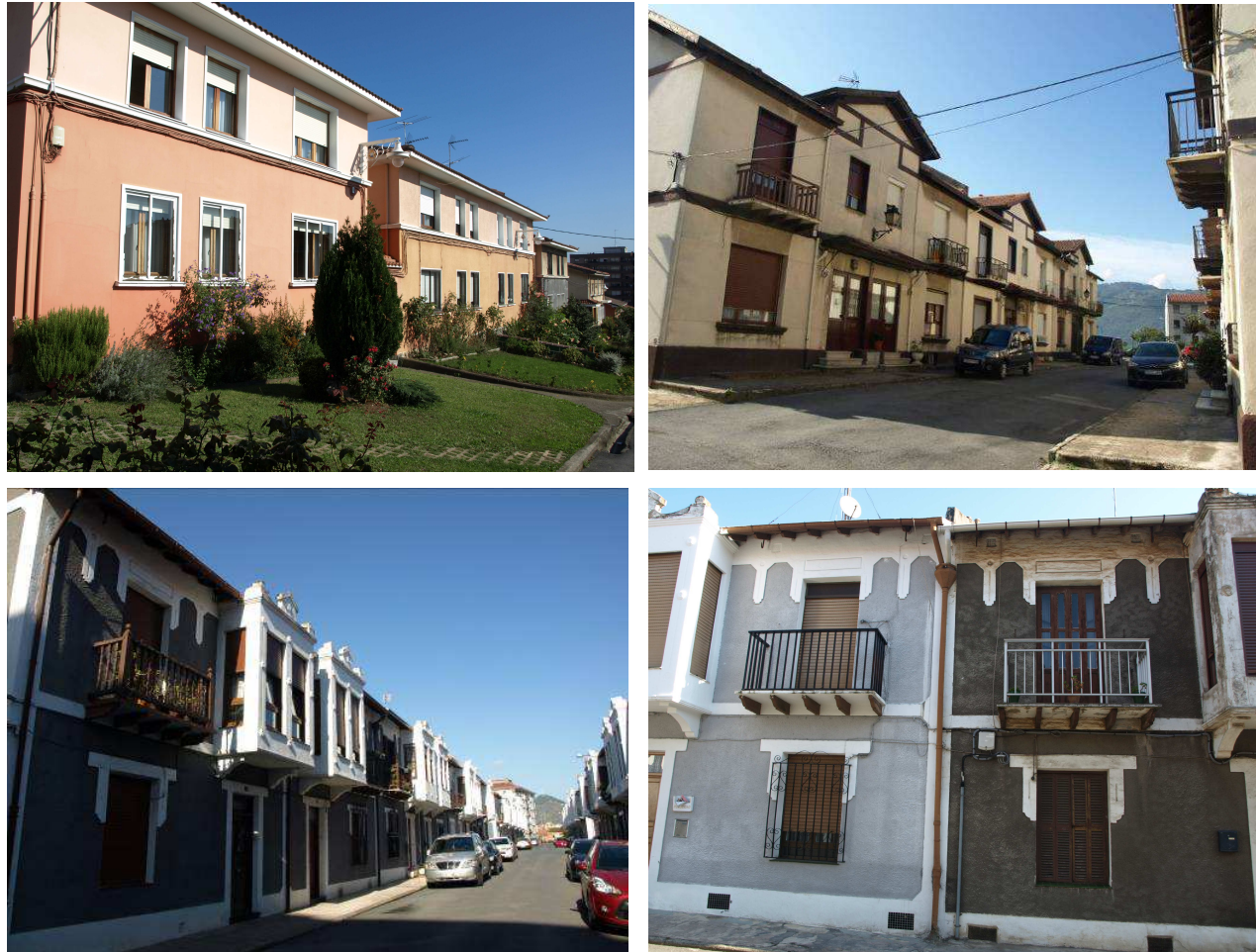
Fig.23.26, 23.27, 23.28 y 23.29: Intervenciones Integradas en Conjuntos Edificatorios.
