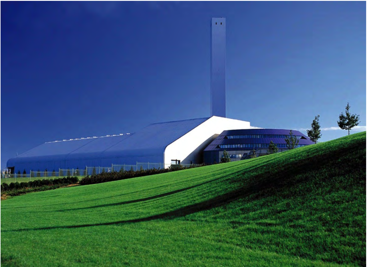
Tornquist Jorrit, Termovalorizzatore Brescia 2000
