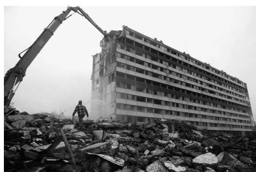
Fig.40. Demolición parcial de los Grandes Bloques. 2001.
