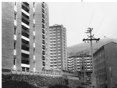
Fig.106. Ocharcoaga en fase de obra.
