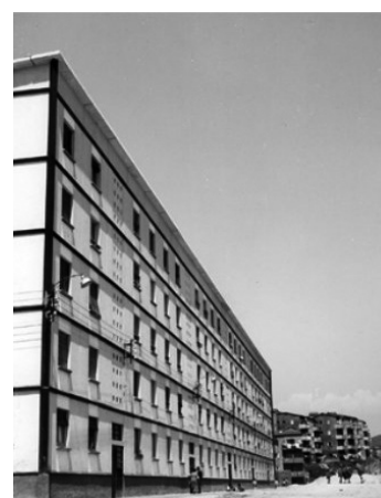
Fig. 101. Fachada principal del bloque prefabricado empleando el sistema Fiorio, en el barrio de la Trinitat Nova.
