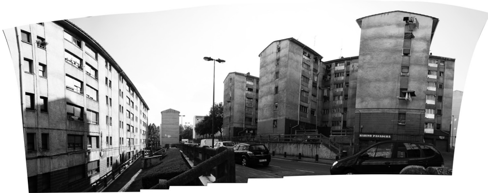
Fig. 128. Bloque nº14 tipo IV. Estado reformado. Solución de fachada: revestimiento mono-capa aislante pigmentada.
