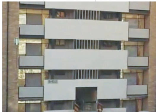
Fig.87. Fachada tipo: composición vertical de franjas de ladrillo cara vista + macizos de mortero de cemento raseo.
