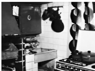
Fig. 109. Reformas en la cocina, eliminando la cocina económica.
