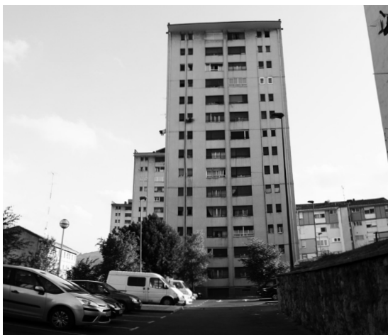
Fig. 127. Bloque nº67 tipo V. Estado reformado. 2012. Solución de fachada: monocapa + pintura.
