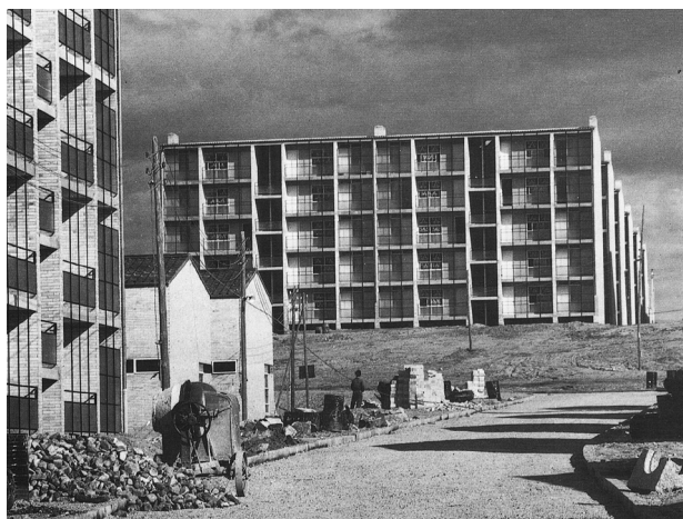
Fig.78. Construcción del Poblado Dirigido de Fuencarral C.
