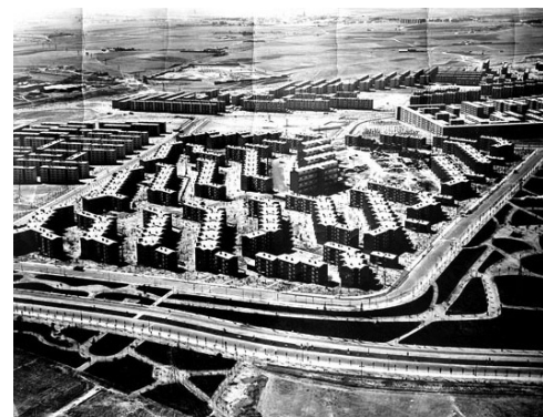
Fig.36. El Gran San Blas. Madrid. 1958-1962 Arq. Luis Gutiérrez Soto, Julio Cano Lasso, José Antonio Corrales y Ramón Molezún
