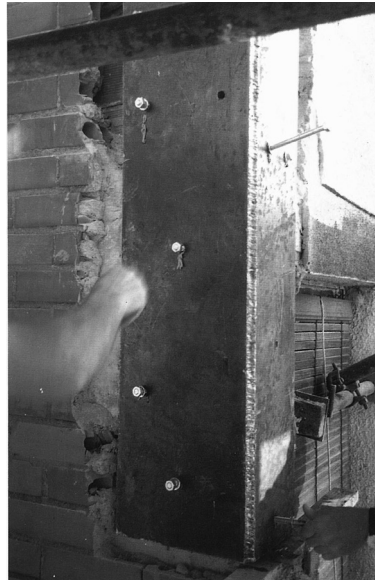
Fig. 117-118. Montaje de refuerzos metálicos en pilares en esquina. Rehabilitación, 1980-1989.
