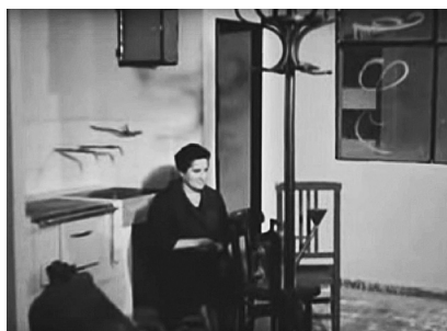
Fig. 108. Estado inicial del interior de la vivienda, zona comedor-cocina. 1961.
