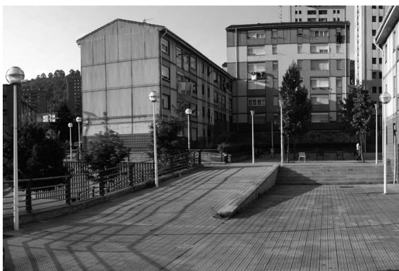
Fig. 130. Bloque nº62 tipo III. Estado reformado. Solución de fachada: Revestimiento aislante ligero.
