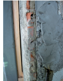
Fig. 129. Bloque nº111 tipo III. Proceso obra, fachada existente de mono-capa aislante con bolitas de porexpan.
