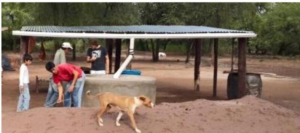
Figura 35. Sistema de captación de agua de lluvia y cisterna hecha por ISF Argentina en la comunidad del Negro [41]
