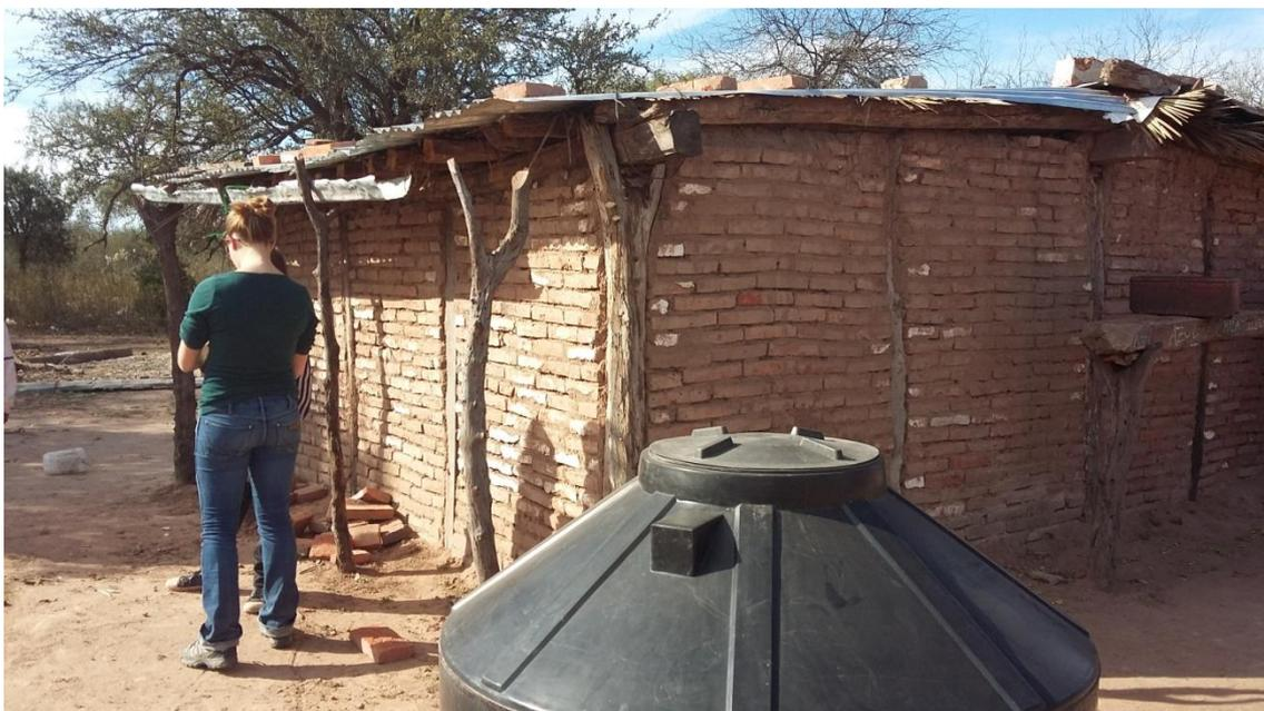
Figura 17. Casa de ladrillo con tejado de chapa y canaleta para conectar en época de lluvias con un bidón de 1000 litros
