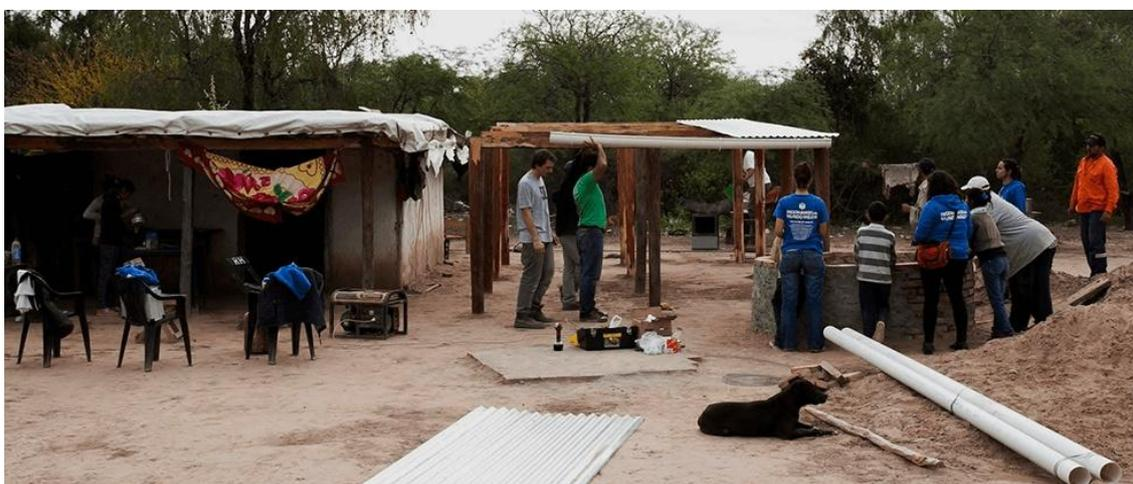
Figura 30. Construcción de techo de chapa para sistema de captación de agua de lluvia. ISF Argentina en la comunidad del Negroito [41].
