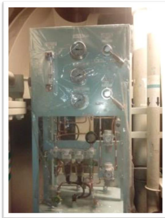
Ilustración 16 Unidad de control de aire
