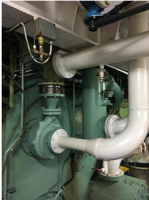
**Figure 11. Bomba de refrigeración acoplada a motores principales (Fuente: propia)**
