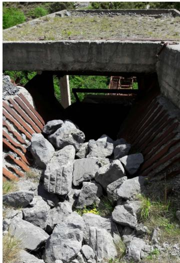
Figura 23. Estructura B Atxarte. Boca de entrada del material a triturar.
