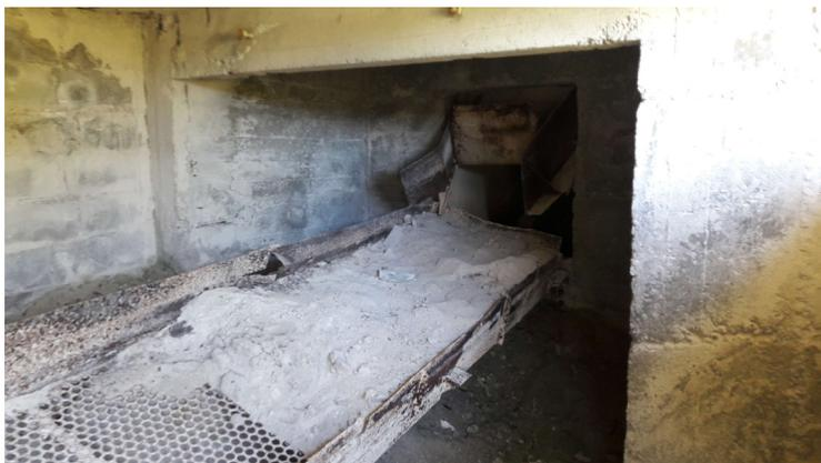
Figura 15. Detalle cinta transportadora de material triturado.
