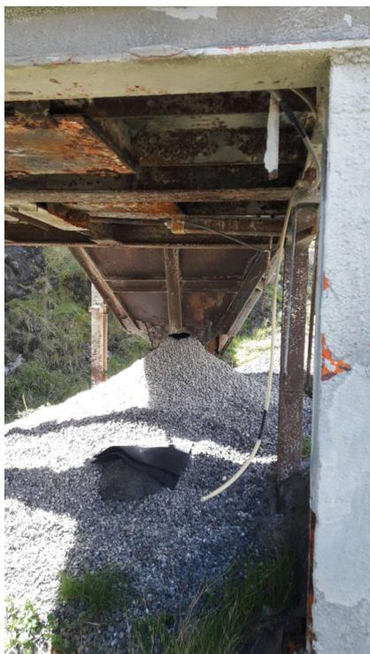
Figura 47. Detalle tolva y material triturado.
