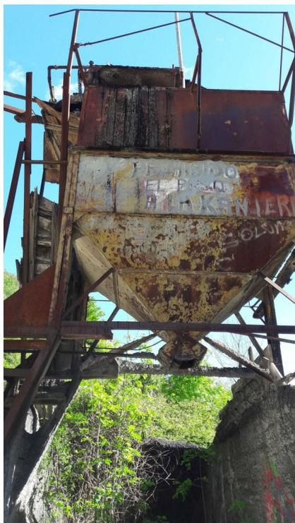
Figura 3. Detalle mal estado tolva.
