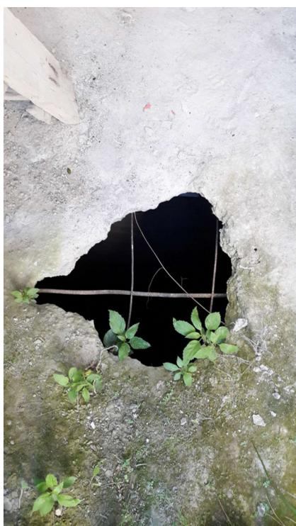
Figura 12. Detalle de hueco en forjado.
