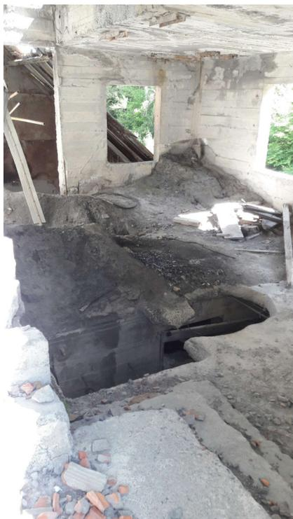
Figura 32. Forjado semiderruido estructura principal.
