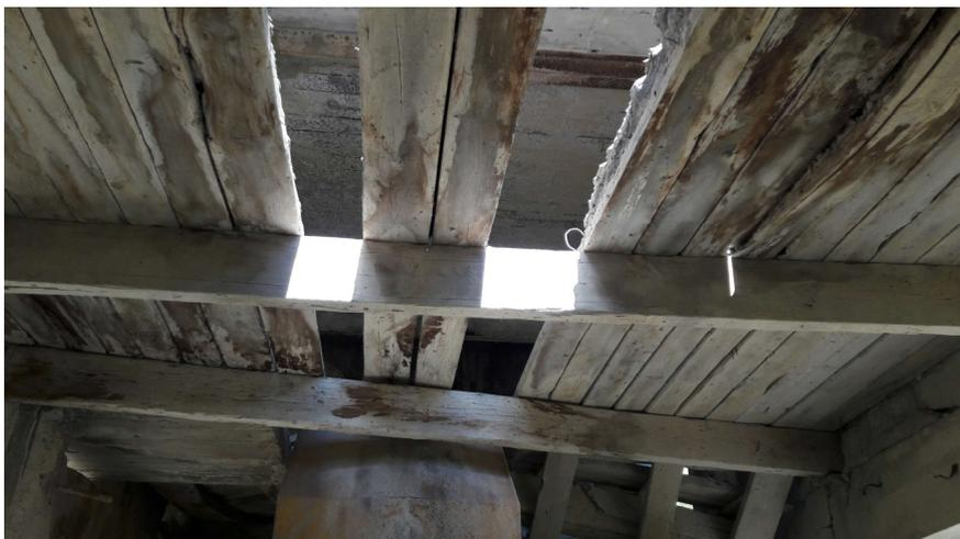
Figura 19. Forjado auxiliar y apuntalamientos de madera.
