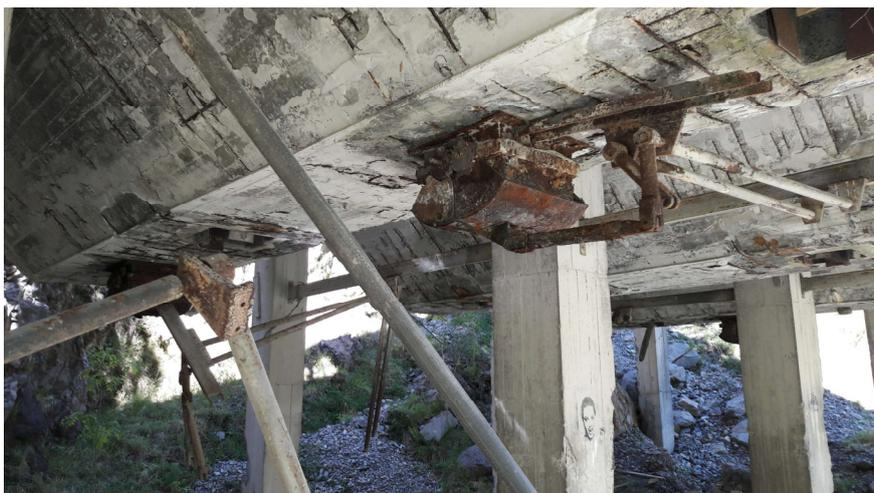
Figura 29. Vista inferior estructura tolvas. Puntos de descarga de material triturado.
