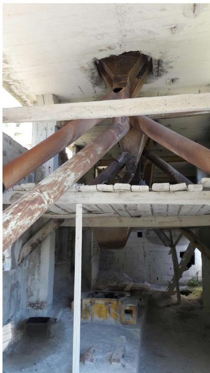
Figura 13. Tolva multidireccional estructura principal.
