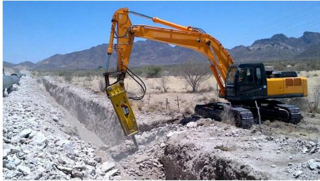
Figura 6. Martillo hidráulico sobre máquina. Fuente: Google.
