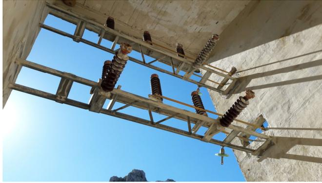
Figura 16. Detalle de la toma eléctrica de la estructura principal de Atxa Txiki.
