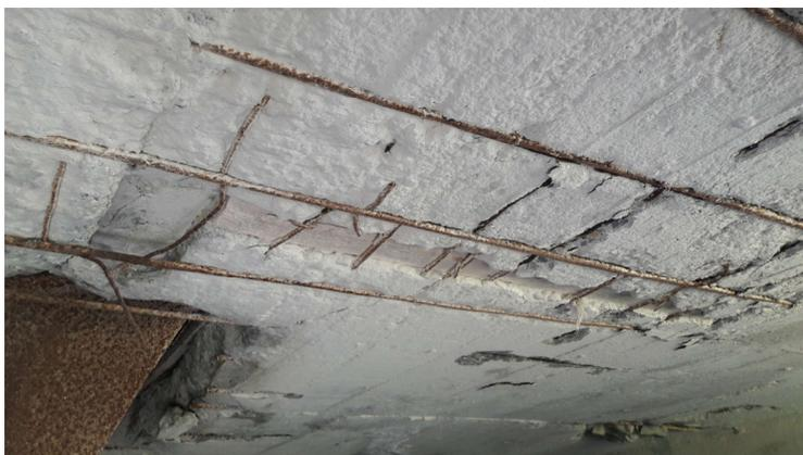
Figura 14. Detalle mal estado forjados y armado.
