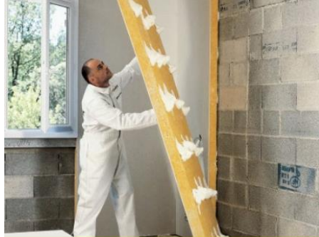
4.16. Irudia: Trasdosatu zuzeneko sistemen instalazioa. (Isover)
