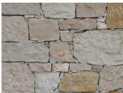
Figura 2. 2: Fachada de piedra
