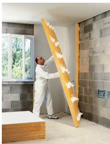
6.13. Irudia: Trasdosatu zuzeneko barnetik egindako isolamendu sistema. (ISOVER)
