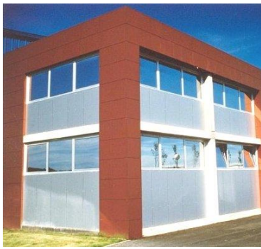
4.12. Irudia: Presio altuko plaka ijestu trinkoen bidez sortutako estaldura (HPL). (Trespa).
