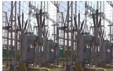
Figura 2. Captura de pantalla del video 3D grabado en la Subestación Eléctrica Texcoco, de CFE. Fuente: Elaboración propia
